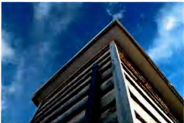
Fotografía N° 16: Tubería de ventilación caseta [REDACTED]
