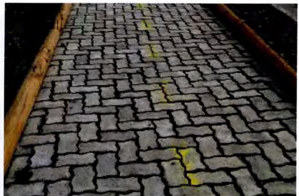
Fotografía N° 28: Pintura de demarcación ciclo vía, en plaza municipal Tito Obreque.
