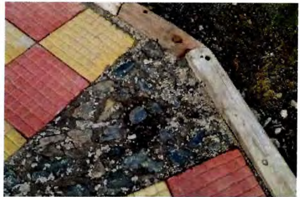
Fotografía N° 26: Pavimento de hormigón lavado, en plaza municipal Tito Obreque.
