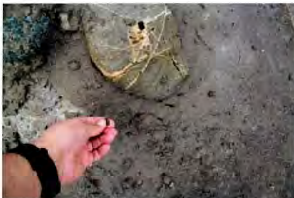
Fotografía N° 13: Hormigón de fundaciones Hito de acceso comunal.
