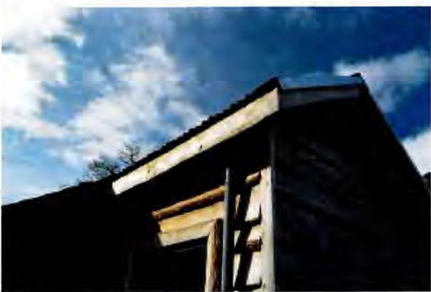
Fotografía N° 17: Tubería de ventilación caseta [REDACTED]
