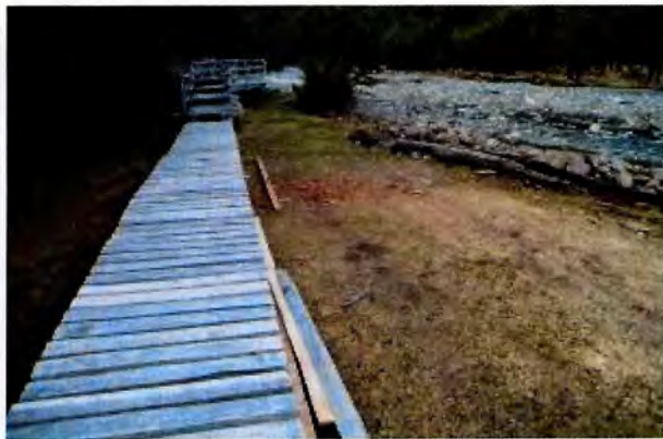
Fotografía N° 6: Aseo Huella de Acceso Pasarela Peatonal Río Mosco.
