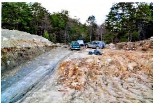
Fotografía N° 47: Ausencia de personal en obra, en zona relleno sanitario.
