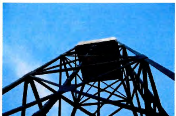
Fotografía N° 30: Estructura torres de estanques de Soluciones Sanitarias.
