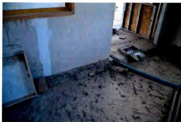
Fotografía N° 2: Estado de obra Ampliación Prebásica Pioneros del Sur.
