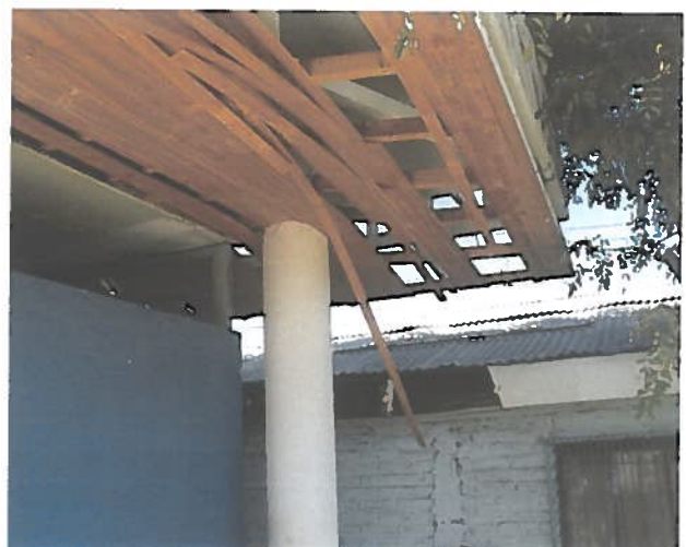
Fotos N os 9 y 10 Entablado de alero exterior desclavado y deteriorado.
