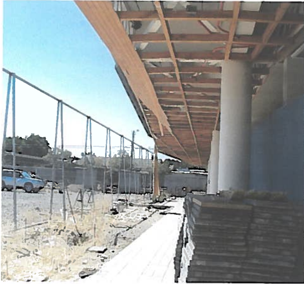
Fotos N os 7 y 8 Entablado de alero exterior desclavado
