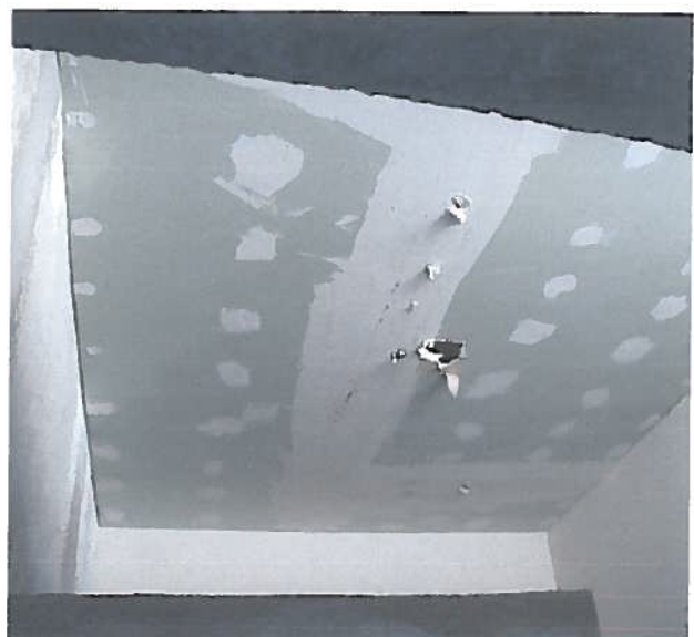
Fotos N os 11 y 12 Planchas de cielo deterioradas por abandono y humedad. Rayados en muros.
