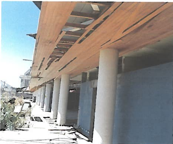
Fotos N os 9 y 10 Entablado de alero exterior desclavado y deteriorado.
