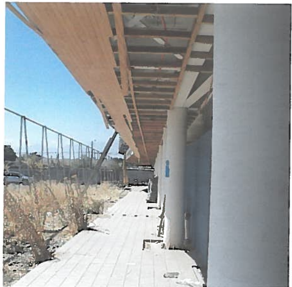
Fotos N os 7 y 8 Entablado de alero exterior desclavado
