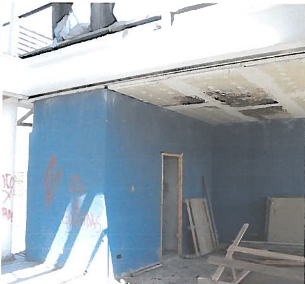
Fotos N os 11 y 12 Planchas de cielo deterioradas por abandono y humedad. Rayados en muros.
