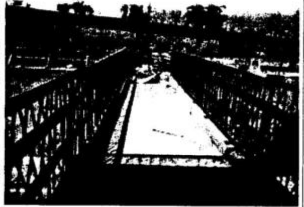
Fotografía N°1: Puente de acceso sur.
