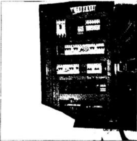
Fotografía N°5: Tablero de distribución de alumbrado y fuerza emergencia N°3, sin espacio para reservas.
