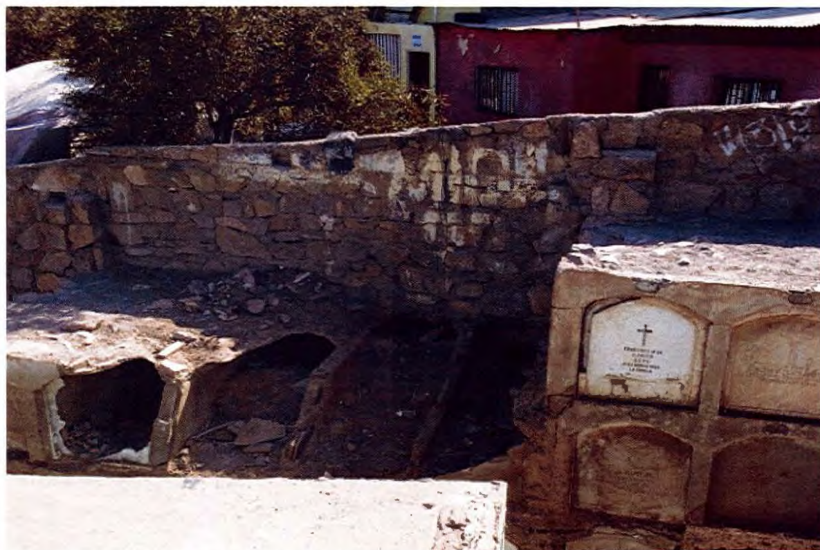
Fotografía N° 2: Vista del muro del sector norte, desde el interior del cementerio.
