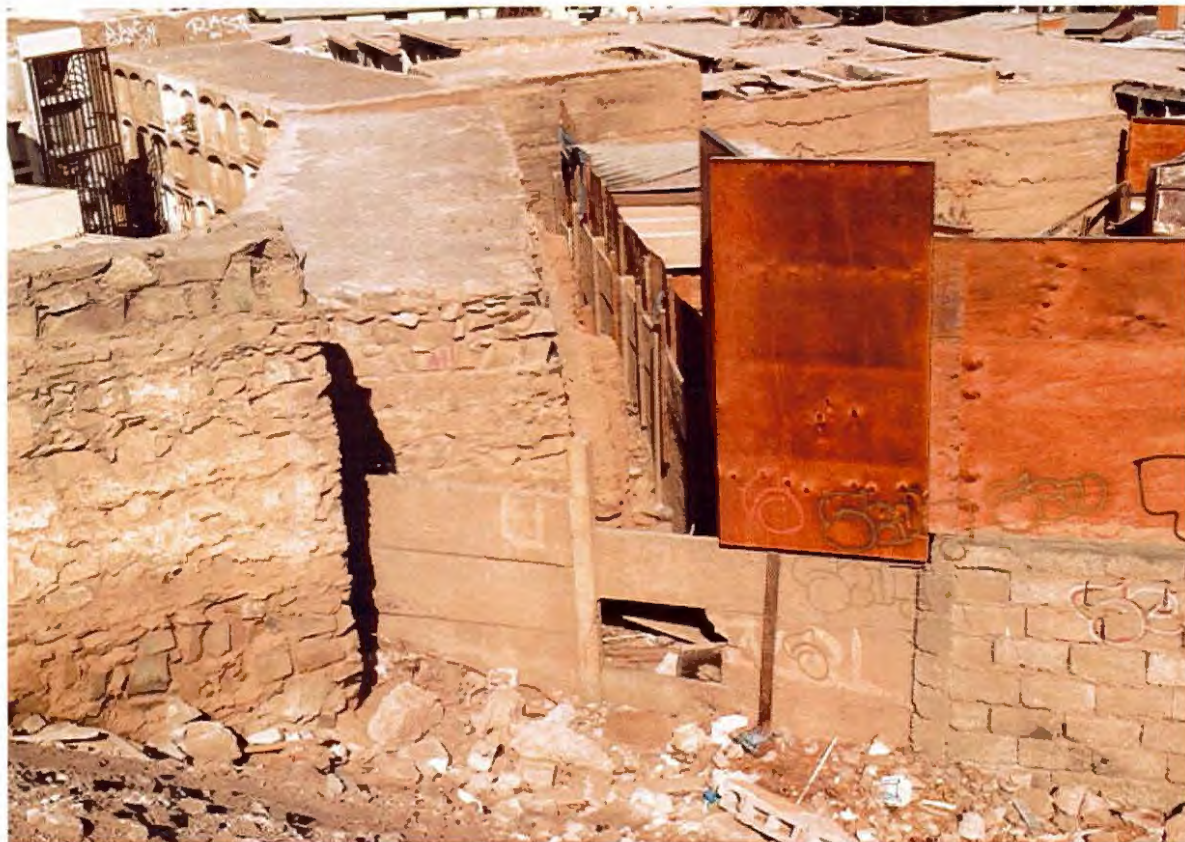
Fotografía N° 1: Muro con altura inferior a 2 metros en el sector norte del cementerio.
