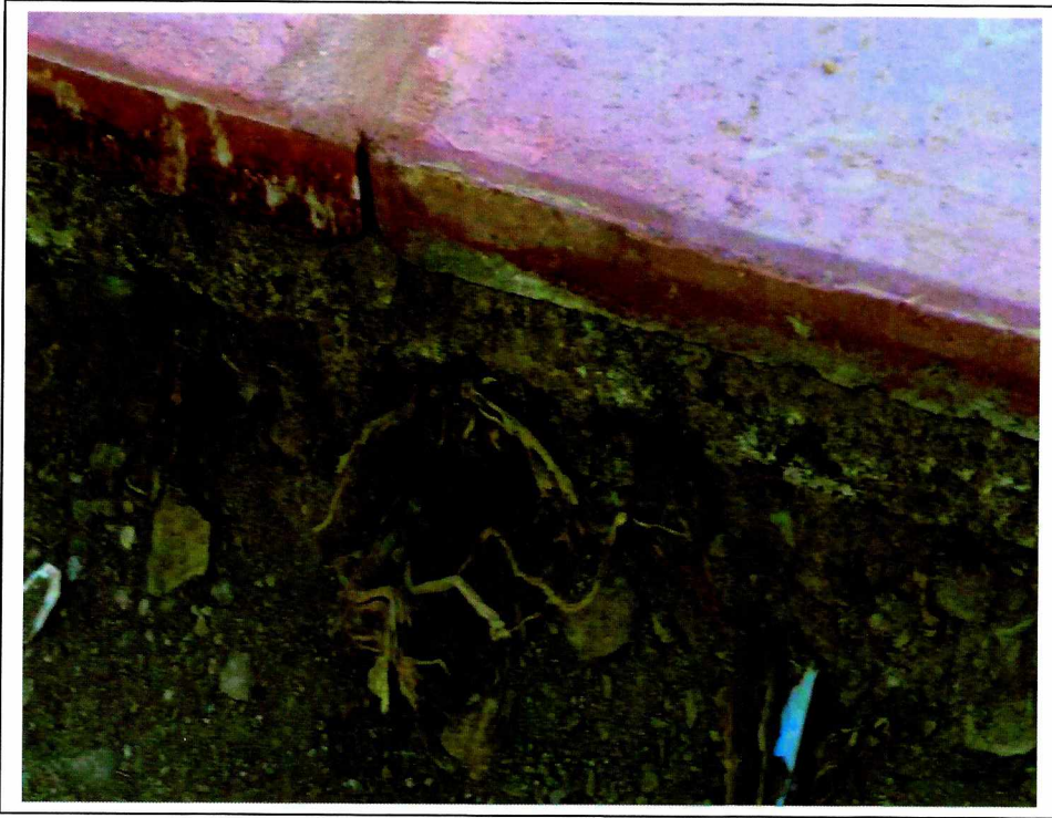
Fotografía N° 36, base de baldosa.
