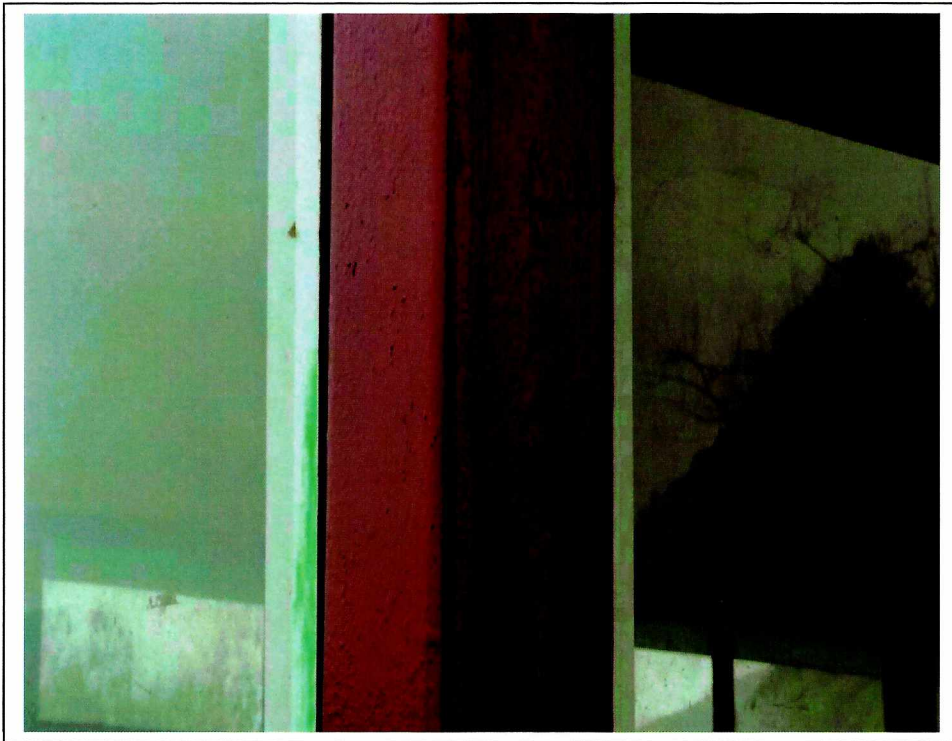
Fotografía N° 16, defectos en pintura interior.
