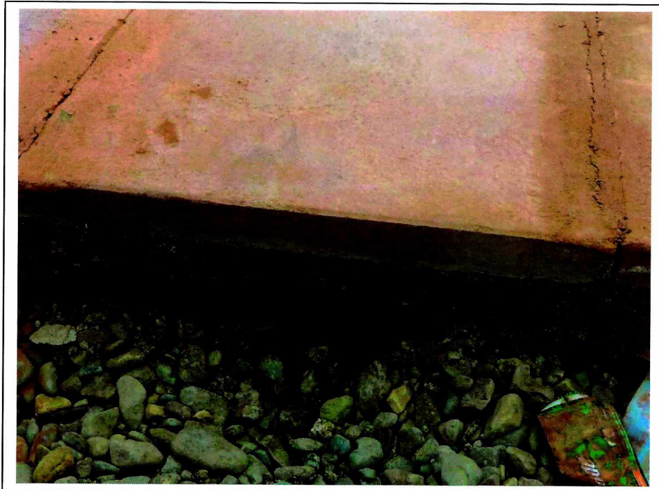
Fotografía N° 37, base de baldosa.
