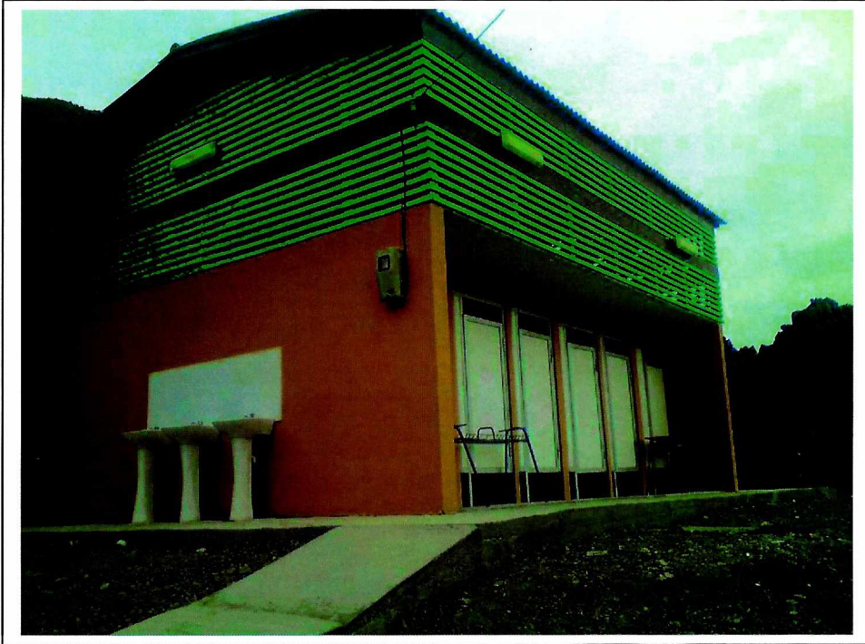
Fotografía N° 3, no se instalaron solerillas.
