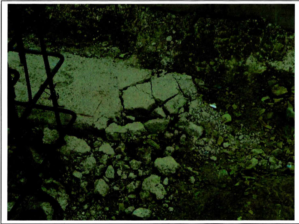
Fotografía N° 32, base bajo de emplantillado de soleras jardinera.
