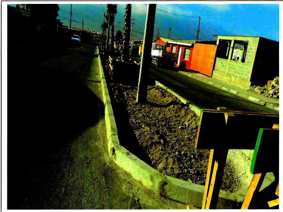
Fotografía N° 29, bandejón sin baldosa y cama de ripio, calle Latorre.
