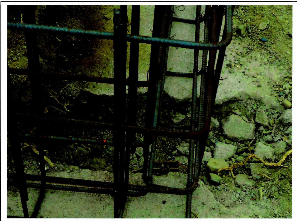
Fotografía N° 33, base bajo de emplantillado de soleras jardinera.
