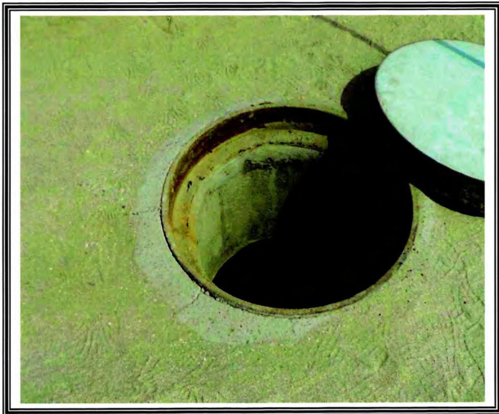
Fotografía N°29, C. I. N°5: Agrietamiento de satélite de refuerzo
