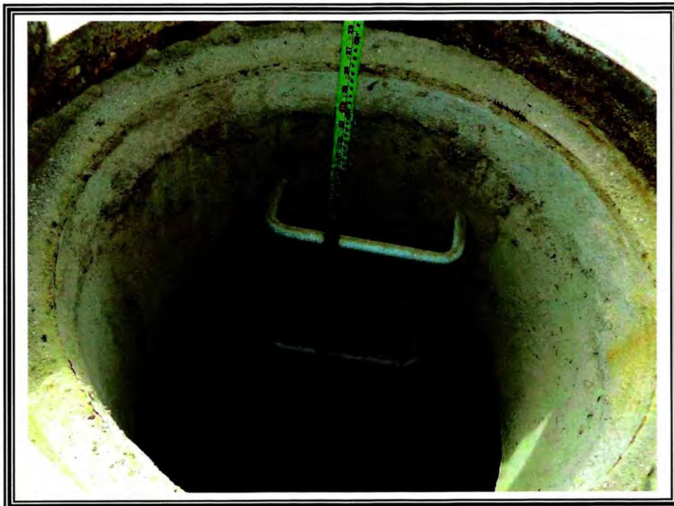
Fotografía N°27, C. I. N°5: Separación de escalines 40 cms
