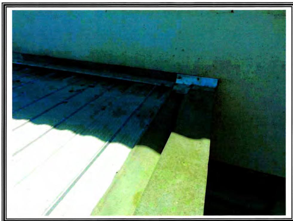
Fotografía N°10, forro de fierro galvanizado existente
