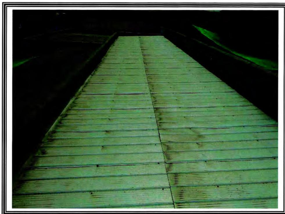
Fotografía N°17, forro de fierro galvanizado existente
