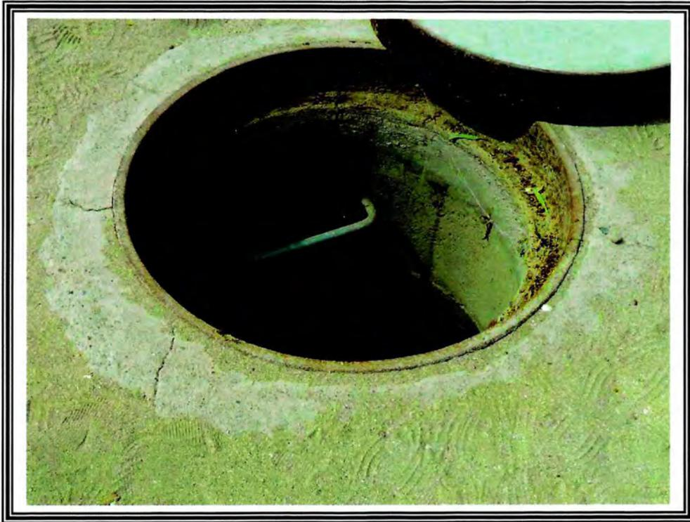
Fotografía N°28, C. I. N°4: Agrietamiento de satélite de refuerzo
