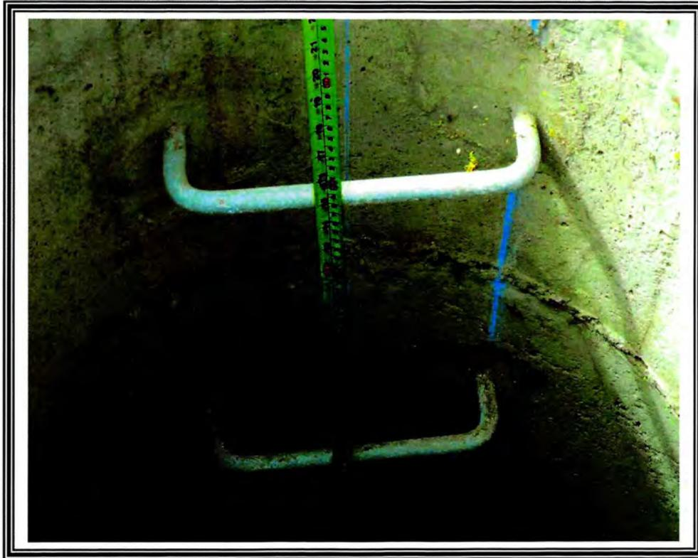
Fotografía N°26, C. I. N°4: Separación de escalines 40 cms
