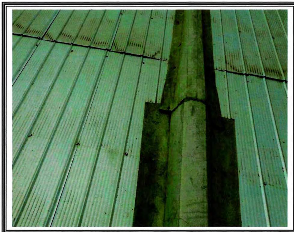
Fotografía N°16, forro de fierro galvanizado existente
