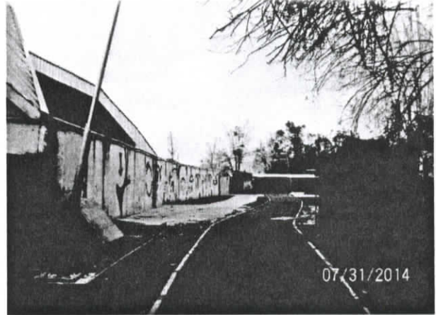
Fotografía N°2 Asfalto de color natural, en el sector norte de Las Parcelas, tramo que cruza el colegio San José Obrero.
