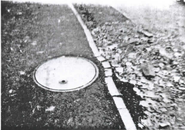
Fotografía N°7 Soleras partidas contiguas a una cámara existente, Entre Las Penas y las Parcelas.
