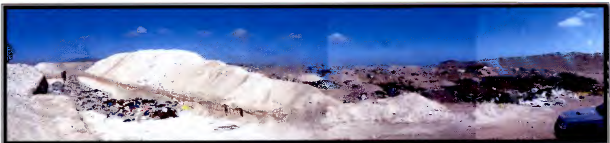
Foto 13: ejecución de una zanja
