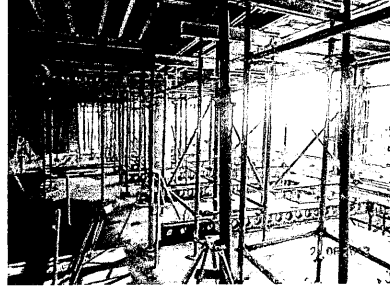
FOTOS N° 25 y 26 INTERIOR SEGUNDO PISO – PREPARACION MOLDAJES LOSA CIELO
