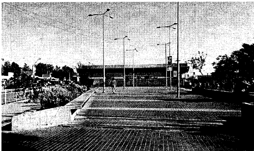
Situación Actual del Terreno
