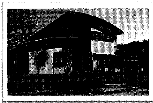
Liceo Nueva Mundo: Pintura exterior perímetro del Establecimiento.
