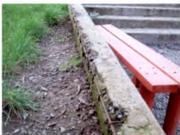
Foto 11: Construcción Plaza Villa Casino Enfierradura de muro a la vista
