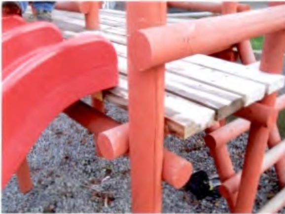
Foto 15: Construcción Plaza Villa Casino Polines sólo con clavos, sin pernos
