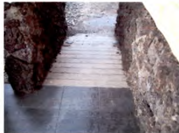
Foto 6: Const. Sede Comunitaria Reflejos del Lago Rampa sin piedra pizarra
