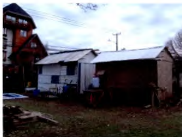
Foto 10: Construcción Plaza Mirador Instalación de faenas de material ligero
