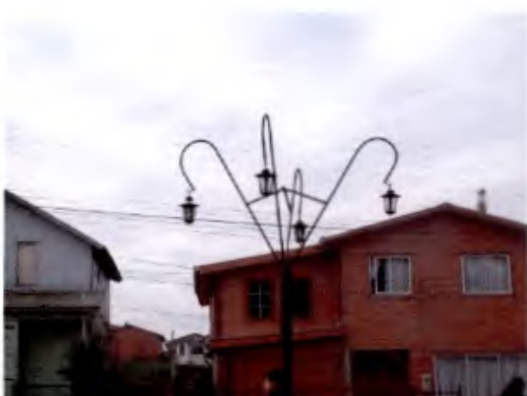
Foto 12: Construcción Plaza Villa Casino Luminarias con cuatro faroles
