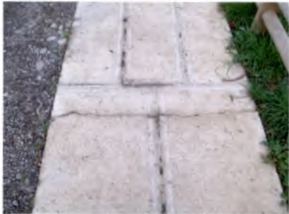
Foto 16: Construcción Plaza Villa Casino
