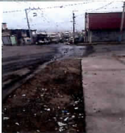
Fotografía N°27 - 09/06/2017 - Paseo Los Pumas Falta de limpieza en sector sur.
