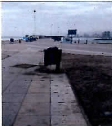
Fotografía N°20 - 06/06/2017 - Parque La Almeja Piso manchado con líquido percolado de basura en sector norponiente.
