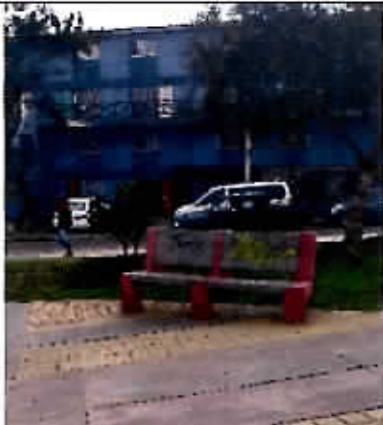
Fotografía N°6 -06/06/2017-Parque Nicolás Tirado Escaños de hormigón rayados con grafiti sector centro
