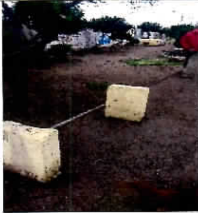
Fotografía N°36 – 09/06/2017 – Paseo Victor Farias Escaño en mal estado sector sur
