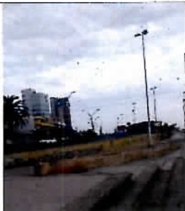
Fotografía N°14 - 06/06/2017 - Parque La Almeja Pintura de soleras en mal estado sector suroriente
