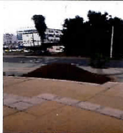
Fotografía N°14 -06/06/2017- Parque Nicolás Tirado Montículos de material en sector sur.
