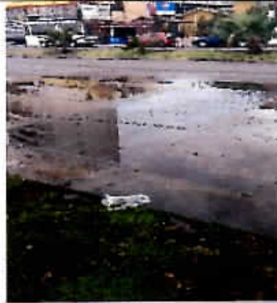
Fotografía N°24 - 06/06/2017 - Parque La Almeja Falta de limpieza en zona de tránsito peatonal en sector oriente.
