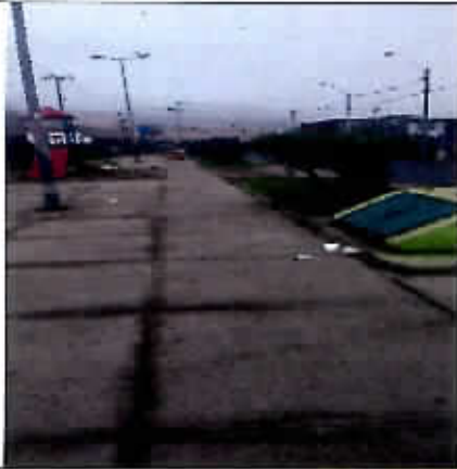
Fotografía N°25 - 09/06/2017 - Paseo Los Pumas Restos de basura en zona de tránsito peatonal.
