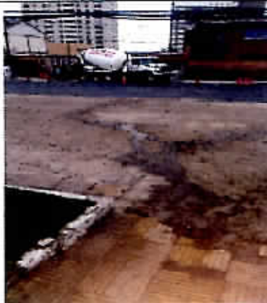
Fotografía N° 10 -06/06/2017- Parque Brasil Riego por inundación y escurrimiento de agua superficial en áreas duras y blandas
