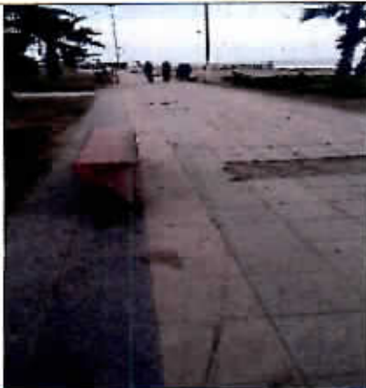
Fotografía N°23 - 06/06/2017 - Parque La Almeja Falta de limpieza en zona de tránsito peatonal en sector poniente.
