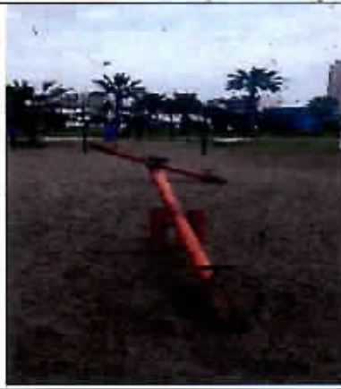
Fotografía N°15 - 06/06/2017 - Parque La Almeja Falta de pintura de juegos infantiles sector norponiente
