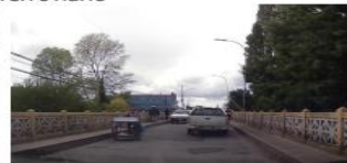
Puente Calle Balmaceda
