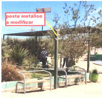
Figura 4. Poste metálico existente en plazas a modificar.
