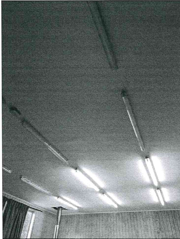
Fotografía 9: Reparación Eléctrica Pabellón 2 Escuela Alberto Córdova Latorre
