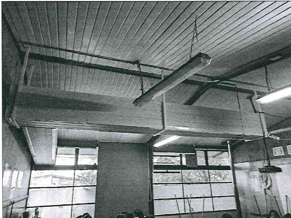
Fotografía 4: vista interior ventilación, obra Conservación escuela Felipe Barthon Corbeaux.
