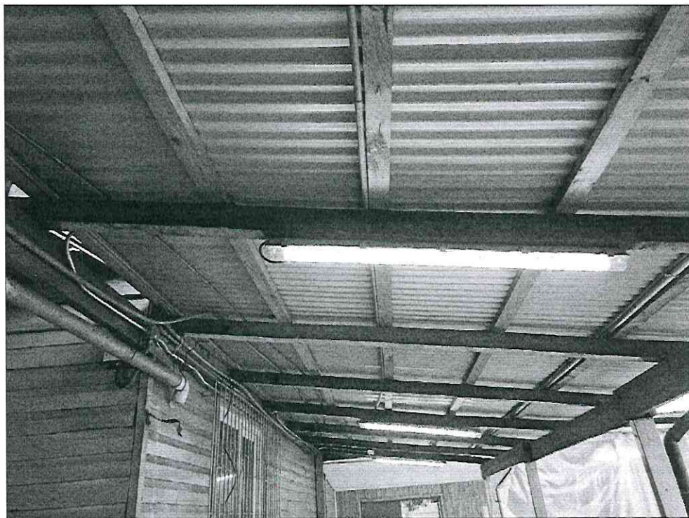
Fotografía 6: Reparación Eléctrica Pabellón 2 Escuela Alberto Córdova Latorre
