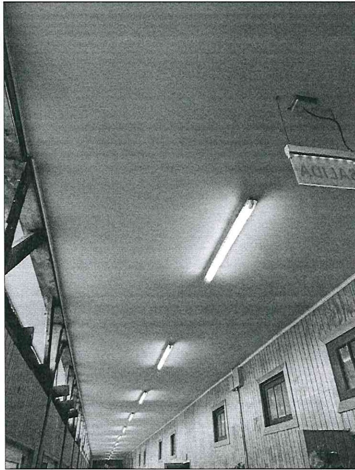
Fotografía 7: Reparación Eléctrica Pabellón 2 Escuela Alberto Córdova Latorre
