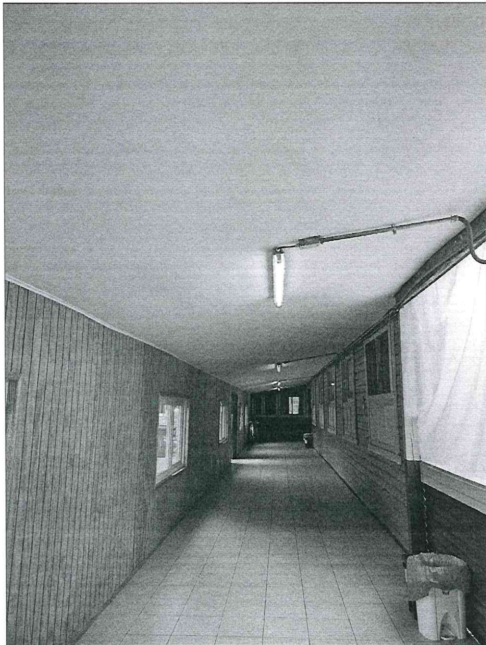
Fotografía 5: vista mejoramiento de infraestructura, obra Conservación escuela Alberto Córdova Latorre.
