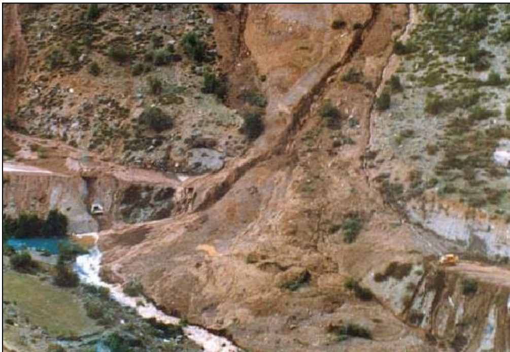
FIGURA Nº 4-1 Flujo de barro ocurrido en el sector de Guardia Vieja, flanco sur río Aconcagua el 18 de Agosto de 1987).
