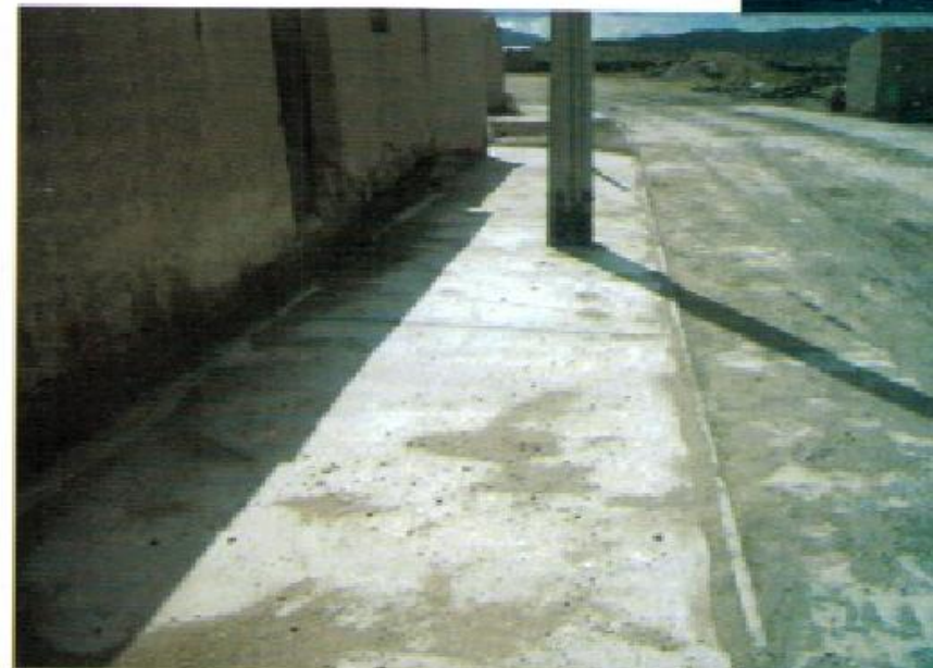
Construcción acera Enquelga
