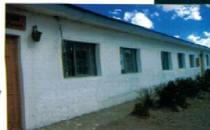
Mejoramiento y Reparaciones Posta y Club Adulto Mayor de Cariquima
