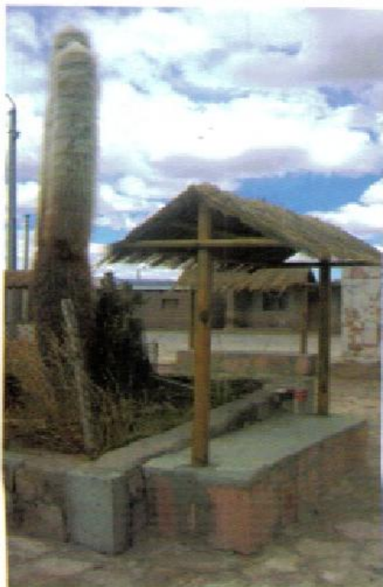
Reparación Plaza Pública de Cariquima
