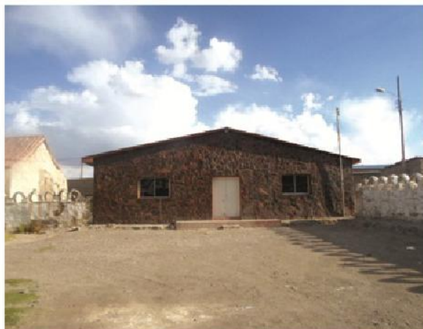
Reparación y Terminación Sede Social de Isluga.
