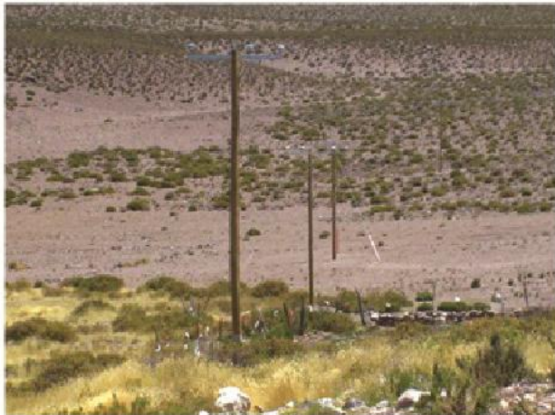
Construcción Red Eléctrica entre Isluga – Enquelga
