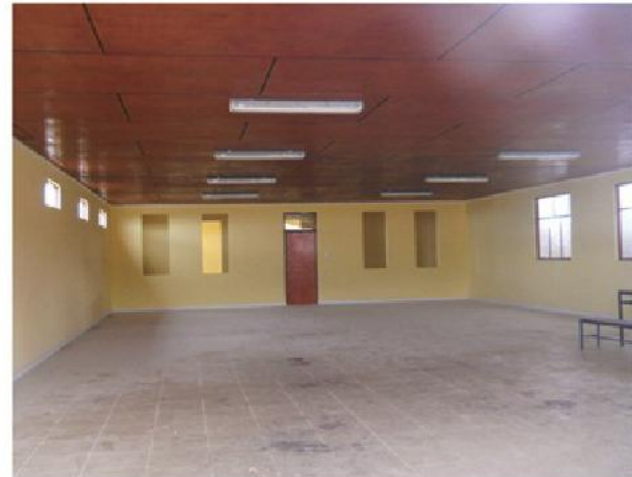
Terminación Sede Social de la Localidad de Pisiga Centro
