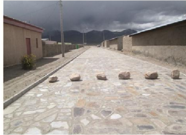
Construcción Calle Principal de Pisiga Choque
