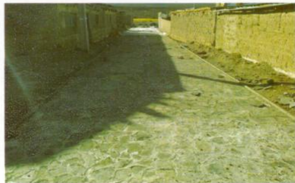
Construcción Pavimentos Calle Nº 1 de Cotasaya Cotasaya $ 77.762.520
