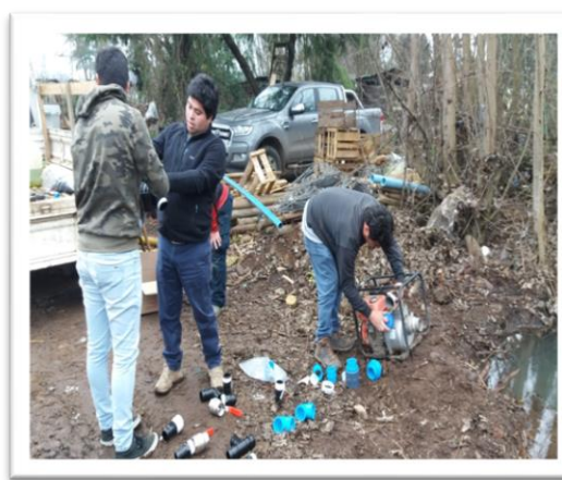
Instalación de sistemas de riego
