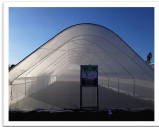
Instalación de invernaderos metálicos
