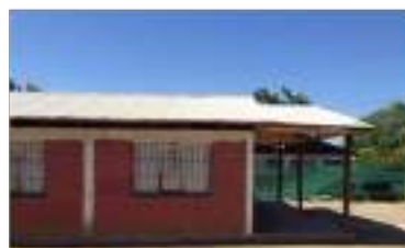
JJVV San Enrique "Mejoramiento de techumbre"
