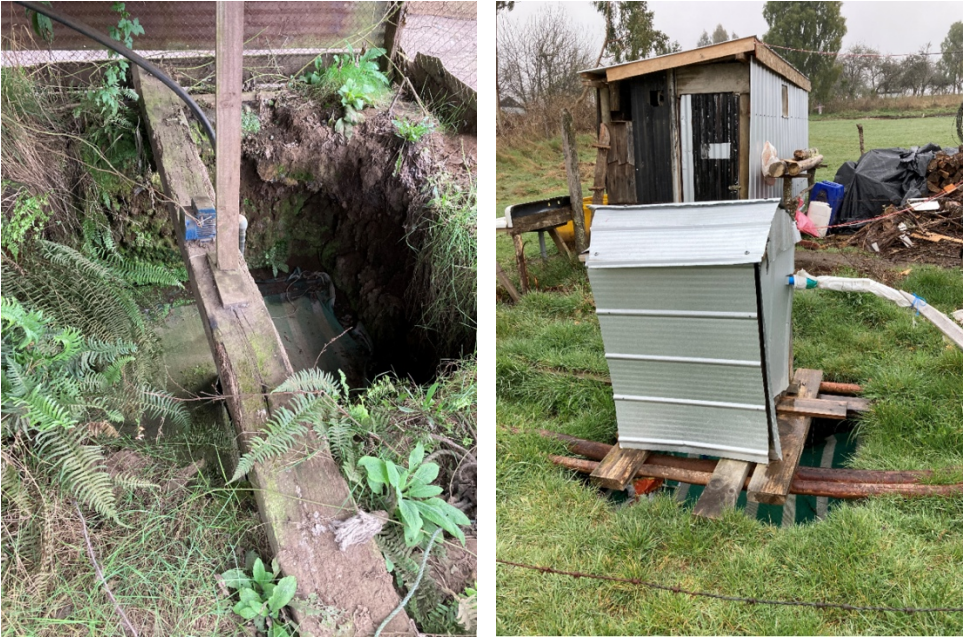
Imagen N°4. Solución existente de abasto de agua sector Colonia Los Indios, comuna de Llanquihue
