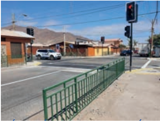
INSTALACIÓN SEMAFOROS EN INTERSECCIÓN JORGE RIVERA CON DAGOBERTO GODOY, AERPOUERTO
