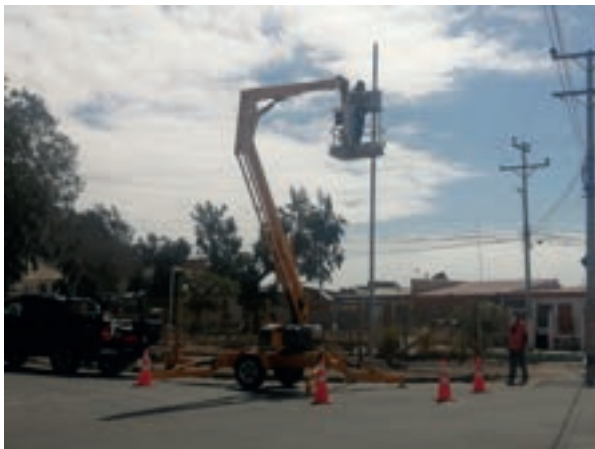
ADQUISICIÓN E INSTALACIÓN DE 12 CAMARAS DE TELEVISION
