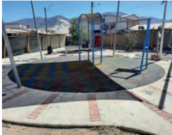
CONSTRUCCIÓN DE PLAZOLETA AERPOUERTO
