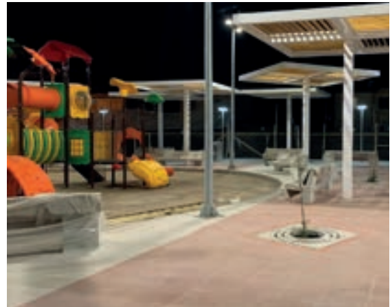
MEJORAMIENTO PLAZA MANUTARA
