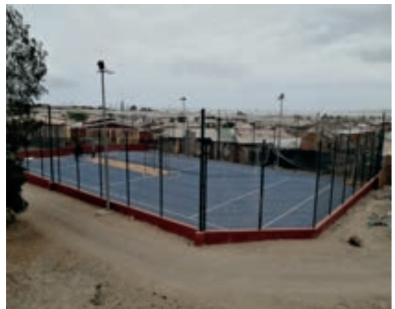
MEJORAMIENTO MULTICANCHA PEDRO AGUIRRE
