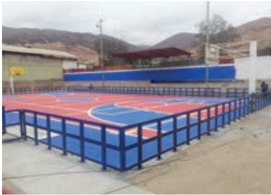
MEJORAMIENTO MULTICANCHA BARQUITO
