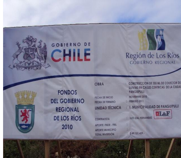
Letrero de la Obra
