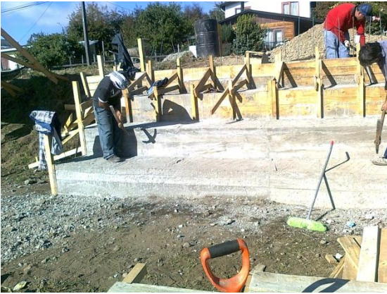
Construcción de Graderías y Canalización del Alumbrado
