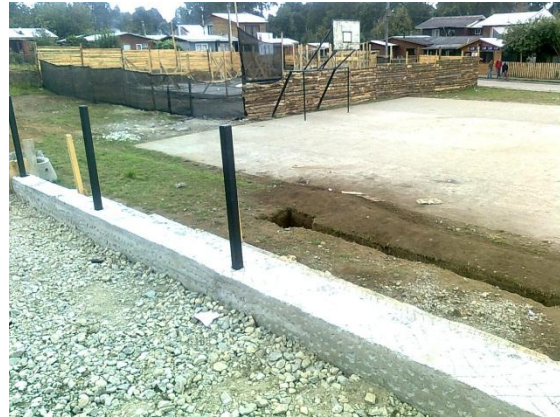
Construcción de Graderías y Canalización del Alumbrado
