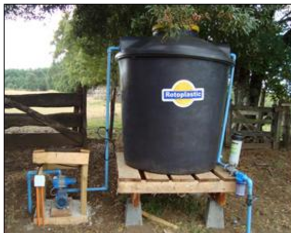
Estanque del agua y accesorios.
