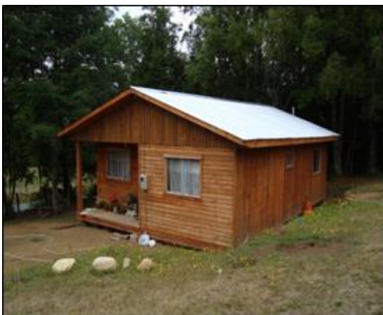
Vivienda Rural de 49,75 m 2 construida en la localidad de Chauquén.
