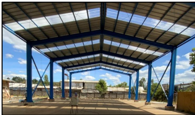
Ilustración 11: Cubierta y mejoramiento multicancha Escuela Ignacio Verdugo Cavada.
