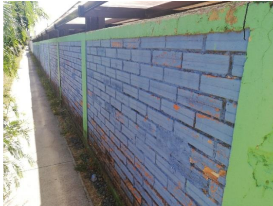
Ilustración 22: Antes muro de albañilería.
