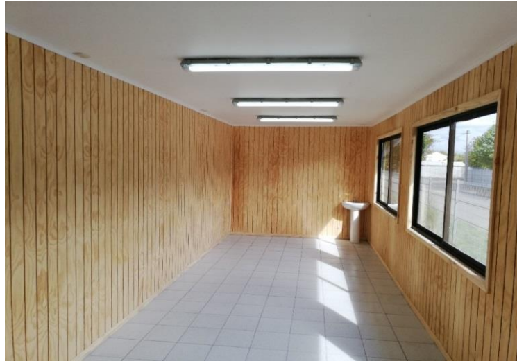
Ilustración 25: Después Sala integración
