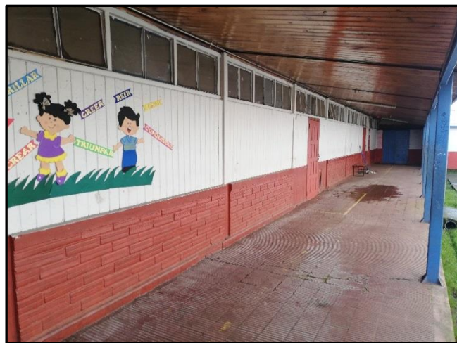
Ilustración 4: Antes pasillo y muro.
