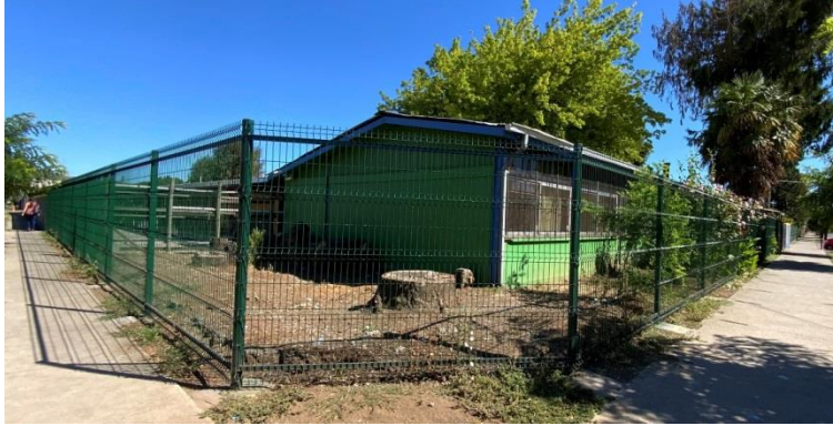
Ilustración 24: Después cierre metálico
