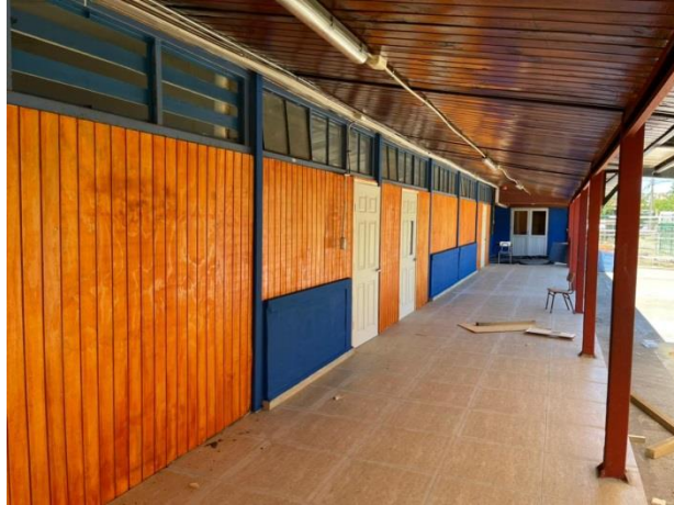
Ilustración 4: Después pasillo y muro Esc. Blanco Encalada.
