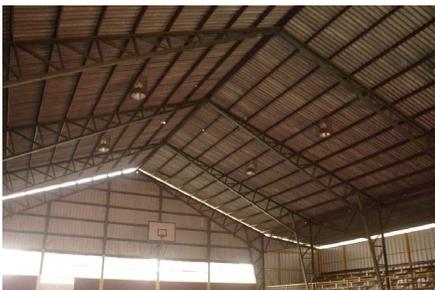
Cubierta con filtración de aguas lluvias, planchas rotas.
