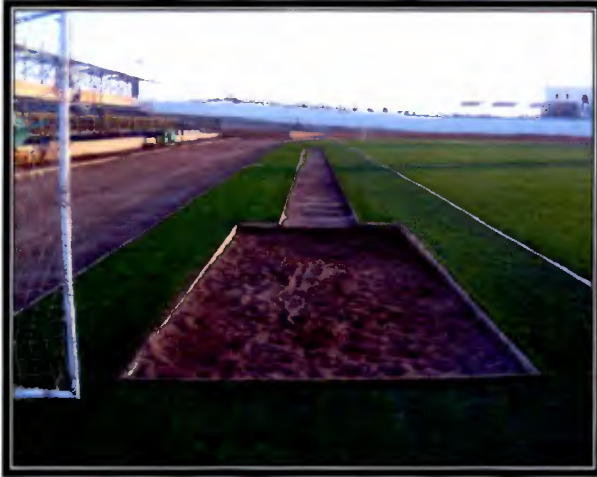
Foto 1: Falta caucho en la carpeta sintética
