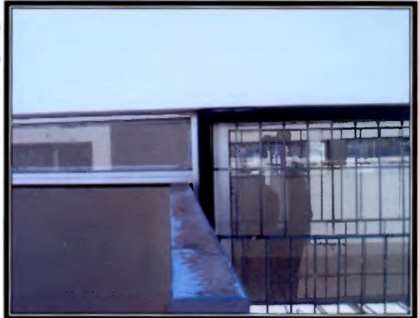
Foto 12: Parte superior de las puertas sin pintar
