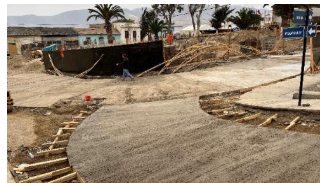
Imagen N° 1: Vista general del avance de las obras.
