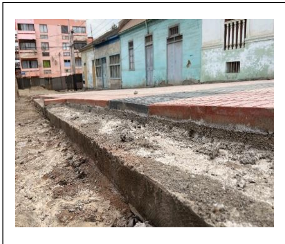
Imagen N°: 24 Fecha captura: 5 de junio de 2023. Ubicación: Calle Carrera, Chañaral. Contenido: Desnivel en baldosas.
