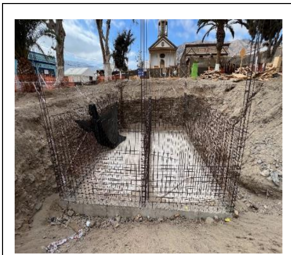
Imagen N°: 3 Fecha captura: 2 de junio de 2023. Ubicación: Estanque de acumulación de agua. Contenido: Modificación de la geometría y disposición del estanque proyectado.
