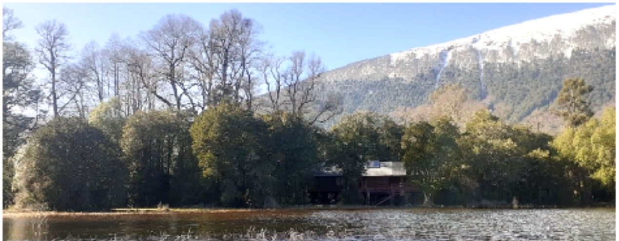
Construcción sobre el humedal
