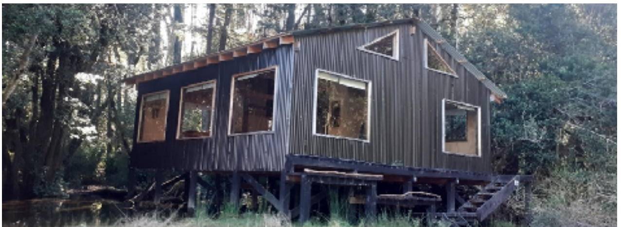
Construcción sobre el humedal
