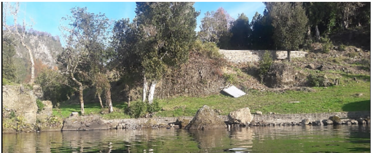
Modificación del borde ribereño por muros de contención
