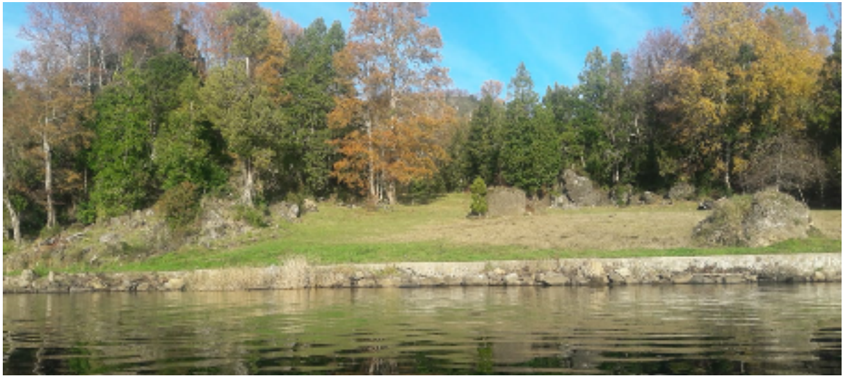
Muro de contención en el borde ribereño
