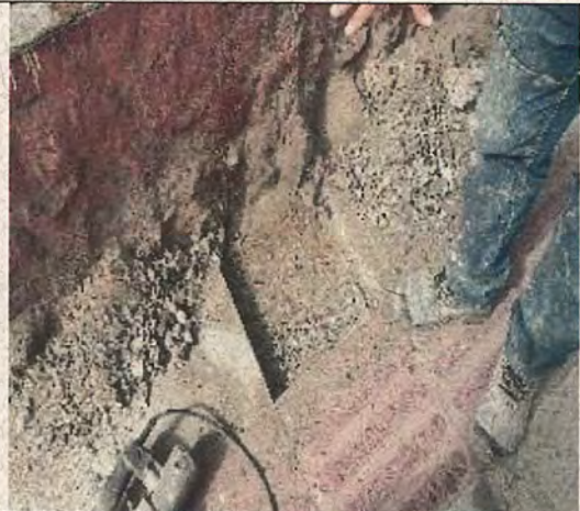
Fotografía N° 16: Baldosa en reposición sin retirar mortero. Calle José Ignacio Zenteno
