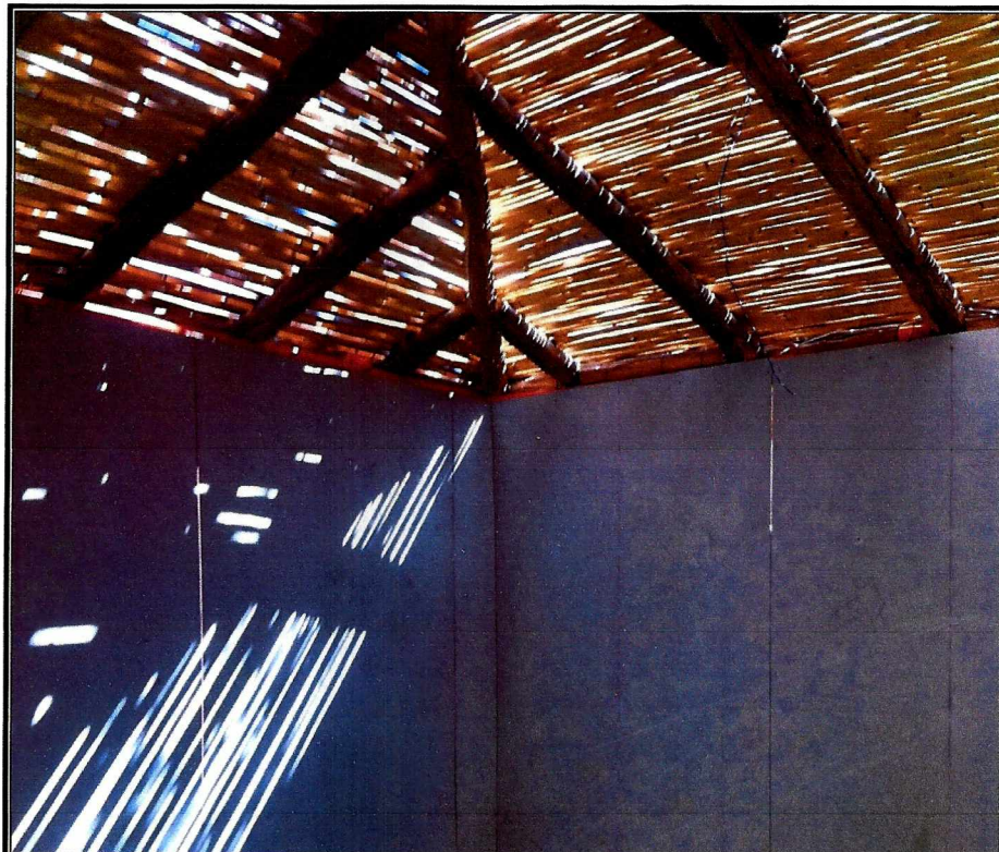
Fotografía N° 1. Planchas de OSB y Cielo falos.
