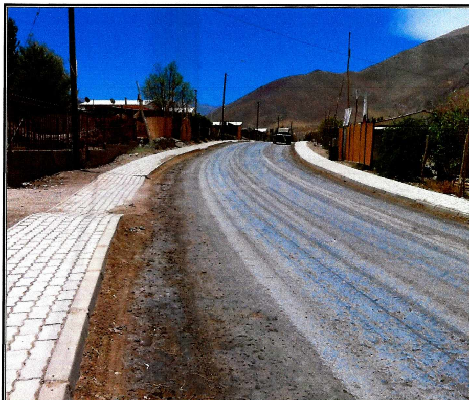
Fotografía N° 17. Distancia entre vereda y pavimento.
