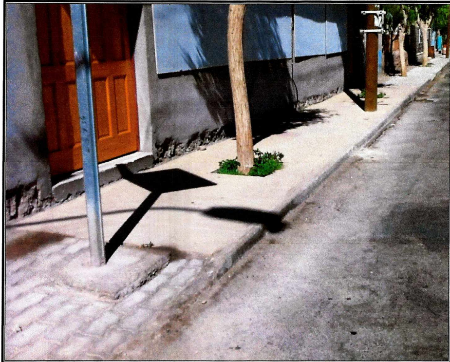
Fotografía N° 12. Adocretos sin instalar.
