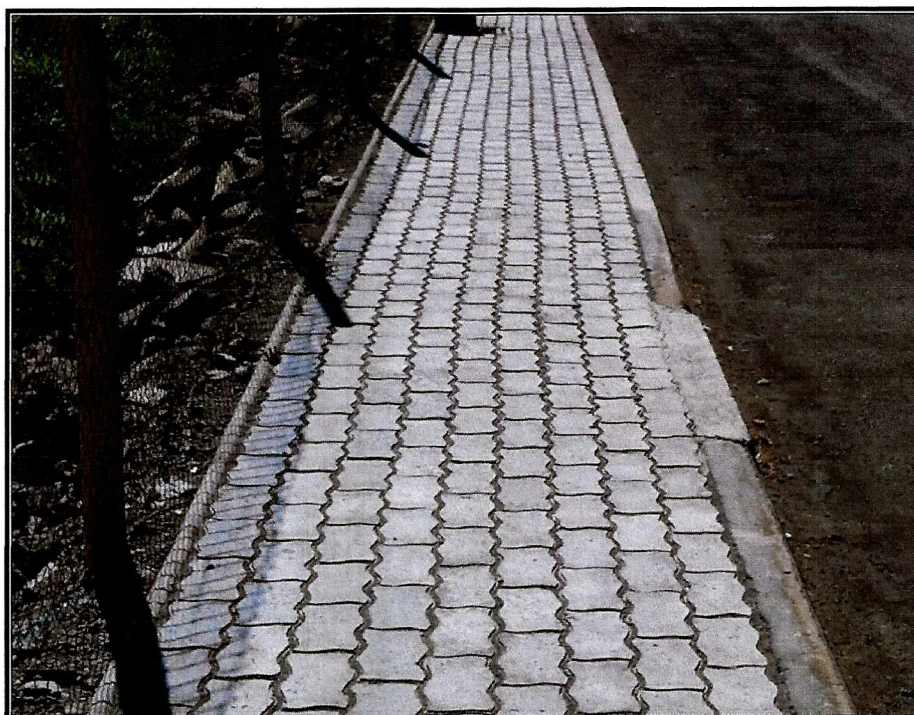
Fotografía N° 14. Instalación lineal de adocretos.
