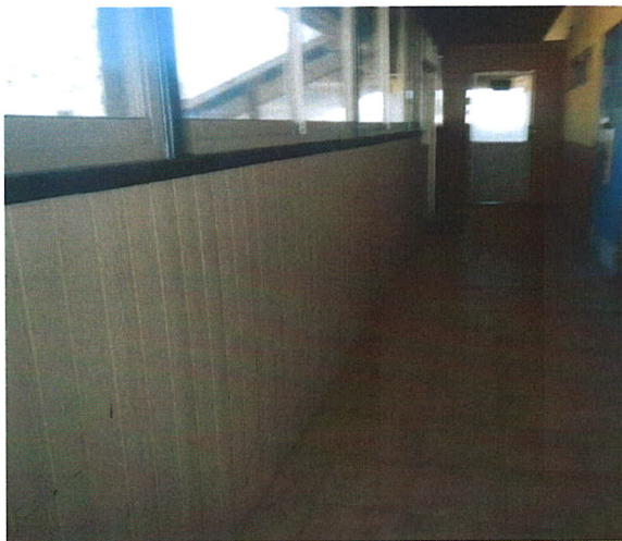
Foto N° 3 Segundo piso sin guardapolvo
