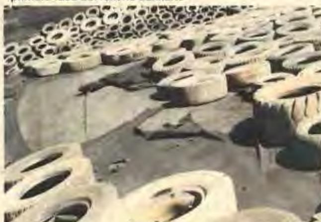
Foto 3: Deterioro del geotextil en el talud lado sur de la primera fase del relleno sanitario.
