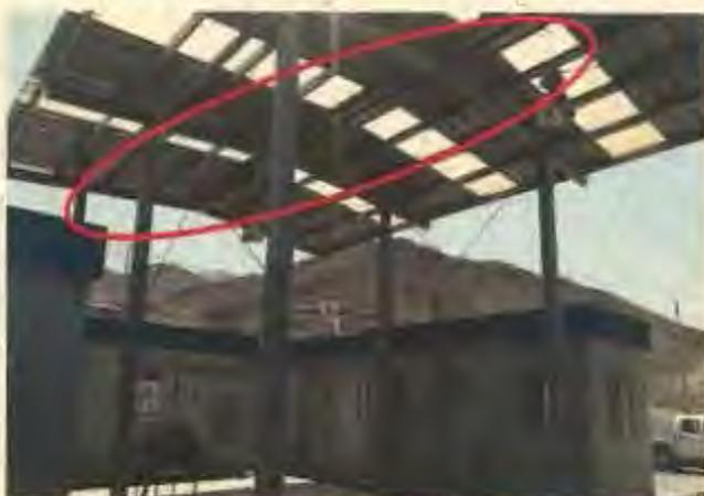
Foto 1: Patio techado de la Administración, no se advirtió la instalación de cuatro (4) perfiles metálicos de 100x100x3 mm.
