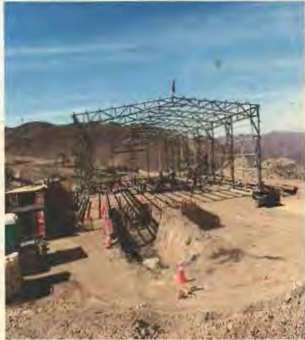
Foto 2: Plataforma N° 2: Planta de reciclaje, ejecución de fundaciones, estructuras metálicas, entre otros.
