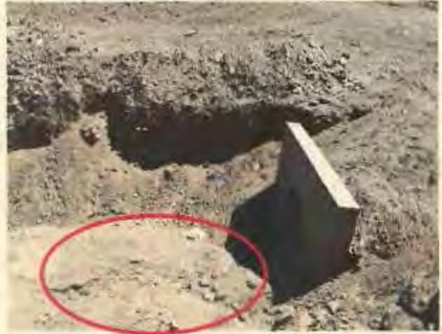
Foto 6: Quebrada N° 1, en el Km 2,180, aprox., sin materialización de enrocado de protección.
