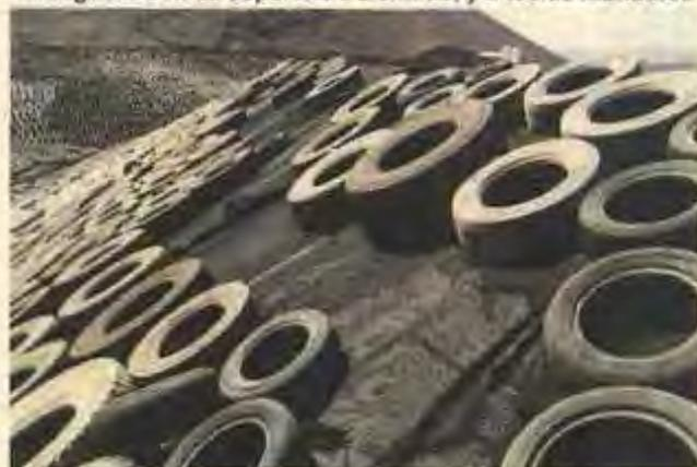
Fotos 5: Deterioro del geotextil en el talud del relleno sanitario -primera fase-
