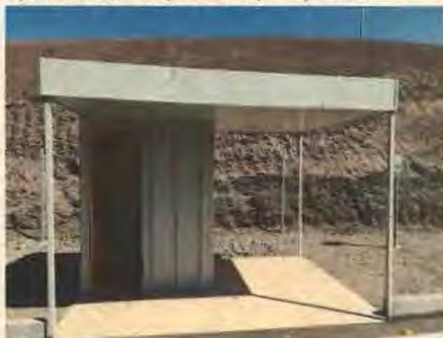
Foto 15: Sala de cambio en el área de Control de acceso, no se ejecutó: muros exteriores, 2 ventanas y 1 puerta.
