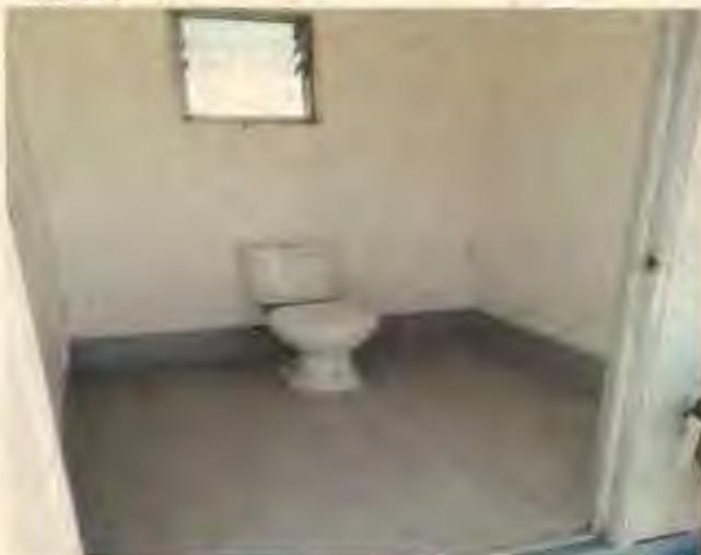
Foto 13: Baño de hombres de la Planta de tratamiento de líquidos no se instaló puerta, tabiquería y urinario.
