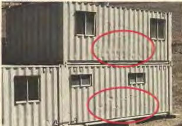
Fotos 6: Contenedores del taller de mantención de máquinas presentan superficies con abolladuras y procesos de oxidación.
