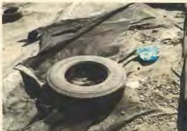
Foto 2: Deterioro del geotextil en parte inferior del relleno sanitario, aprox. en la cámara de captación de lixiviados.
