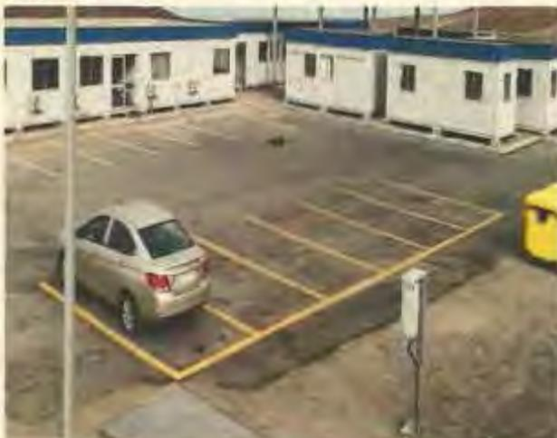
Foto 21: Área exterior del edificio de Administración e instalaciones operacionales, no se instaló las solerillas y topes de seguridad en los estacionamientos, ni pastelones de concreto en las instalaciones, según plano N° ARQ-01
