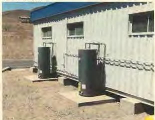
Foto 22: se verificó que los termos eléctricos ubicados en el comedor y los baños y camarines de la Administración, no cuentan con la caseta de protección, según plano N°ARQ-06.
