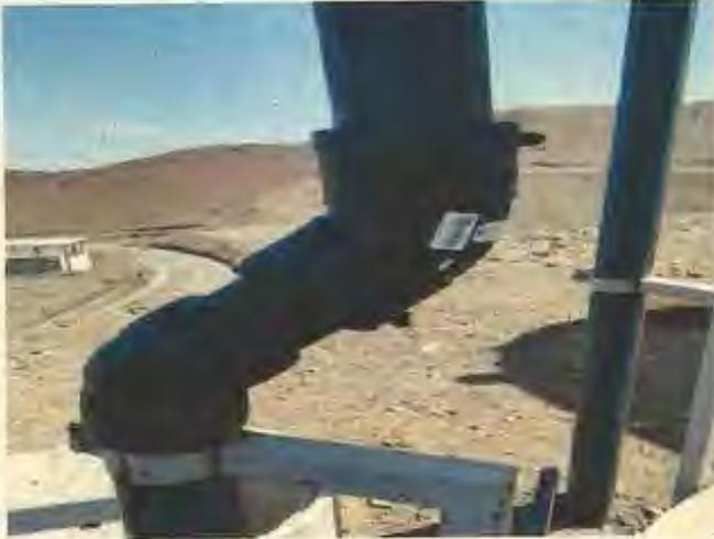
Foto 29: Se verificó que en los estanques de almacenamiento de agua se instalaron piezas especiales de HDPE, en vez de acero galvanizado.
