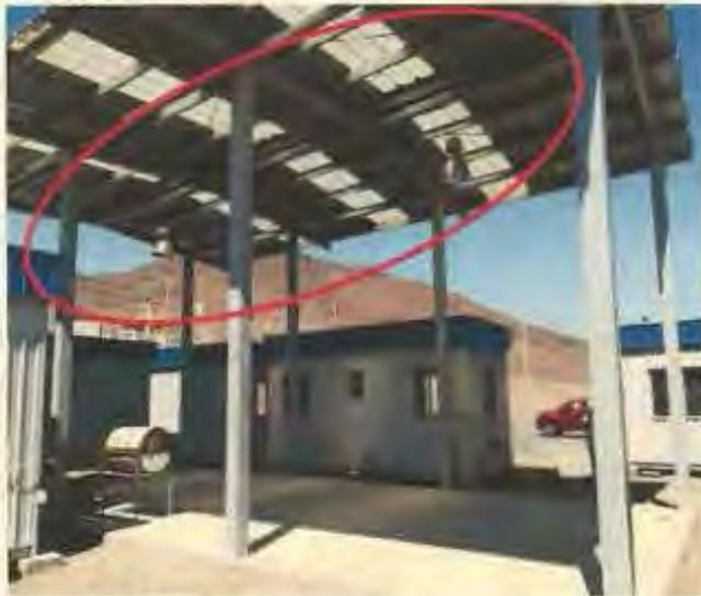
Foto 7: Patio techado de la Administración, no se advirtió la instalación de cuatro (4) perfiles metálicos de 100x100x3 mm.
