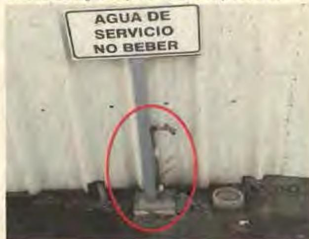
Foto 27: Se constató que todas las instalaciones de arranque del agua de servicio se ejecutaron en forma diferente a lo proyectado.
