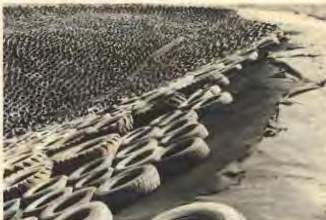
Foto 1: Deterioro del geotextil en el talud lado sur de la primera fase del relleno sanitario
