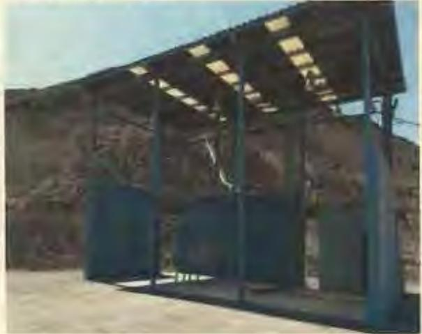
Foto 20: Patio de lavado de camiones, no se materializaron: 2 portones metálicos de corredera, y 1 portón vehicular.
