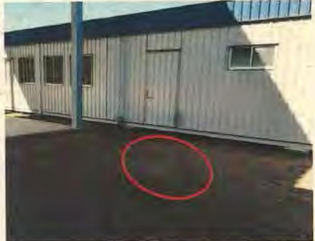
Foto 30: se constató que no se materializó cámara desgrasadora ubicada en el comedor de las oficinas de Administración, según planos ALC-02 y COND-08
