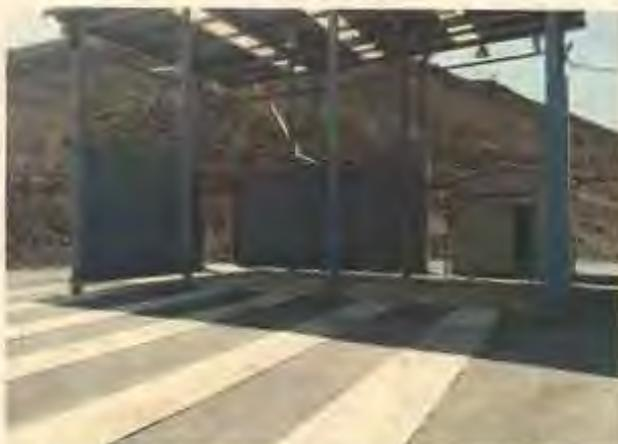
Foto 2: Patio de lavado de camiones, no se materializaron: 2 portones metálicos de corredera y 1 portón vehicular.
