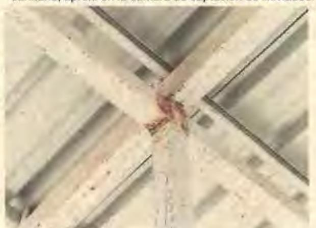
Foto 4: Proceso de oxidación en las estructuras metálicas en la planta de compostaje.
