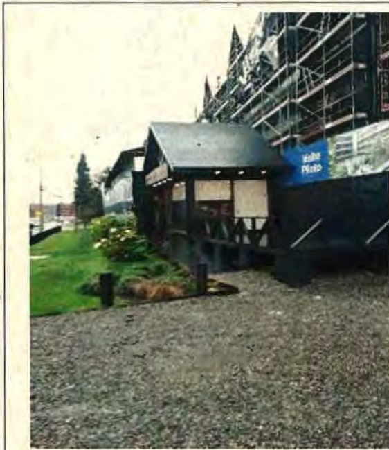
Fotografía N° 1: Vista exterior de departamentos
