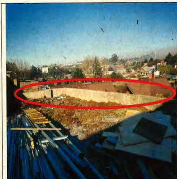
Fotografía N° 1: Coronamiento del muro de contención.
