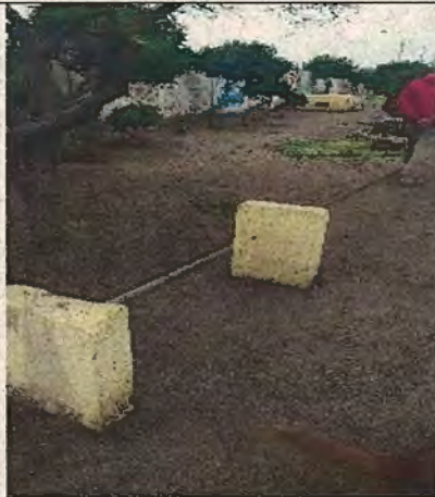
Fotografía N°36 – 09/06/2017 – Paseo Víctor Farías Escaño en mal estado sector sur
