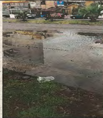
Fotografía N°24 - 06/06/2017 - Parque La Almeja Falta de limpieza en zona de tránsito peatonal en sector oriente.
