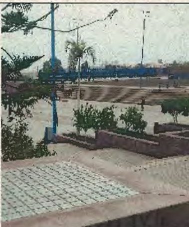
Fotografía N°18 - 09/06/2017 - Plaza Bicentenario Falta de dosificador de agua en sistema de riego según ITS
