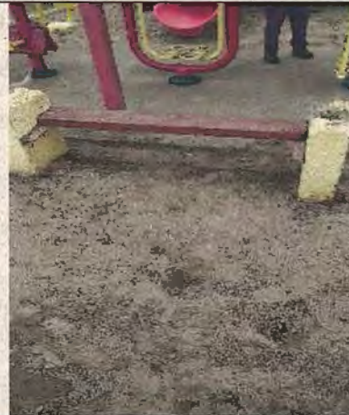
Fotografía N°37 – 09/06/2017 – Paseo Víctor Farías Escaño en mal estado sector centro
