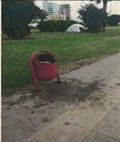
Fotografía N°19 - 06/06/2017 - Parque La Almeja Falta de limpieza de acera manchado con líquido percolado en sector poniente.
