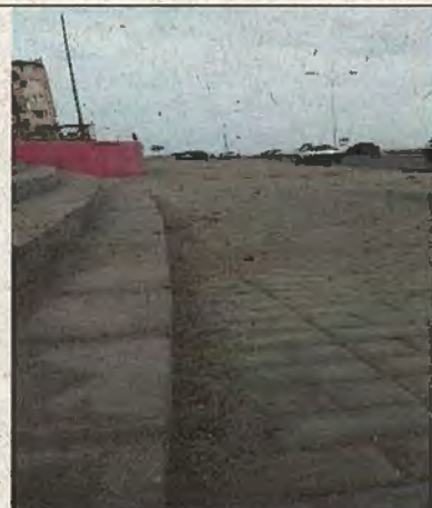
Fotografía N°18 -06/06/2017- Parque Nicolás Tirado Falta de barrido de vereda sector poniente.
