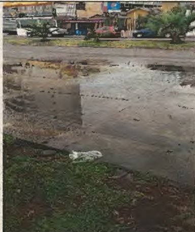
Fotografía N°15- 06/06/2017 - Parque La Almeja Filtración de cañería en sector sur oriente
