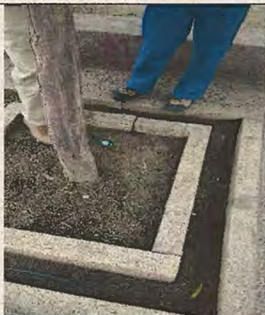
Fotografía N°17 - 09/06/2017 - Plaza Bicentenario Falta de dosificador de agua en sistema de riego de arbolado según ITS
