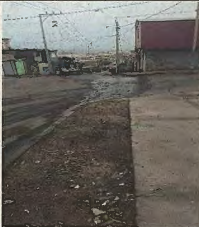
Fotografía N°27 - 09/06/2017 - Paseo Los Pumas Falta de limpieza en sector sur.
