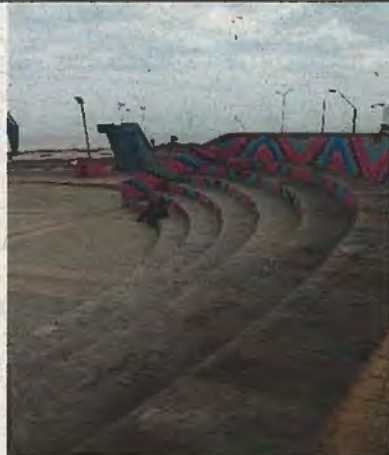
Fotografía N°16 -06/06/2017- Parque Nicolás Tirado Falta de barrido y limpieza en anfiteatro ubicado en sector poniente.
