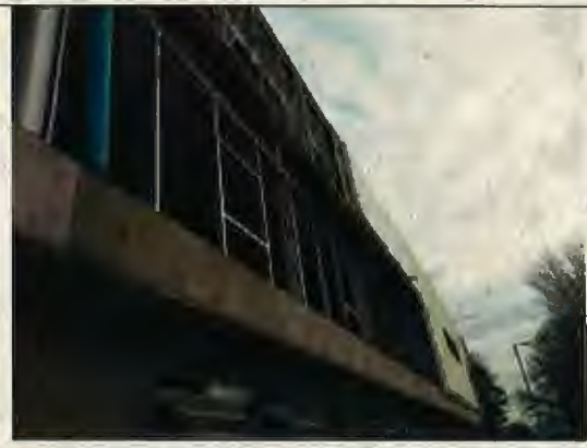
Fotografía N° 2: Revestimiento exterior con poliestireno expandido y sectores sin revestir
