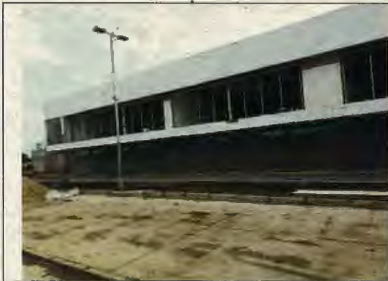
Fotografía N° 1: Revestimiento exterior con poliestireno expandido
