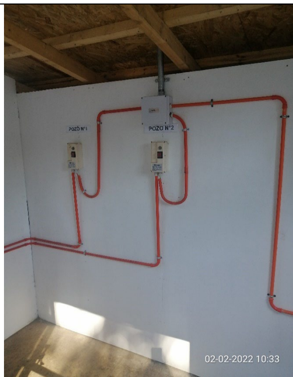
Fotografía N°: 6 Fecha captura: 02-02-2022 Contenido: Conexión eléctrica de los pozos 1 y 2.
