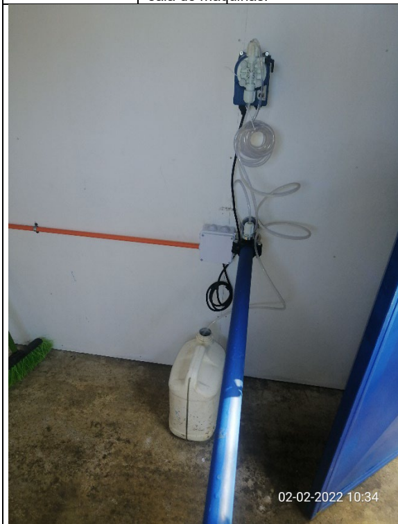
Fotografía N°: 7 Fecha captura: 02-02-2022 Contenido: Vista del Clorador.
