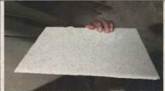
Fotografía N° 10: Cerámica de cocina retirada intacta tras la humedad sin rastros de mortero de pega
