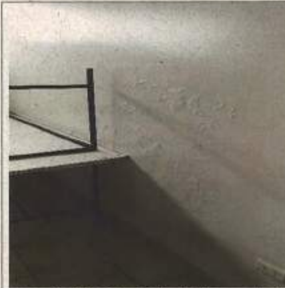
Fotografía N° 7: Muro Salón Multiuso ampliado
