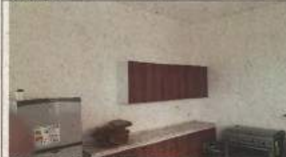
Fotografía N° 11: Estado actual de cocina sin cerámicos en muro
