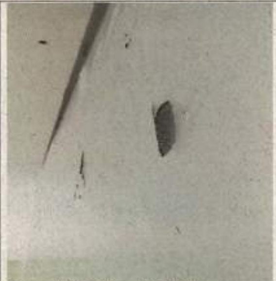
Fotografía N° 8: Muro Salón Multiuso ampliado
