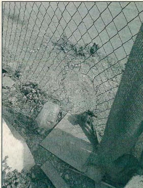
Fotografía 2: Tramos de la parte delantera con sus mallas acma dañadas y rotas.
