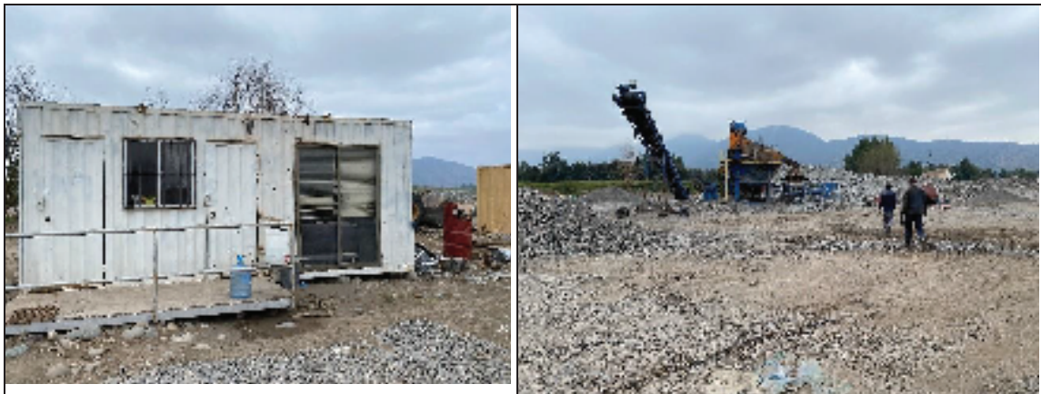
Fotografía N°3 - 16/03/2021: Instalación de faenas de Áridos Santa Barbara. Fotografía N°4 - 16/03/2021: Trabajadores en faenas de extracción de áridos, comuna de Doñihue.
