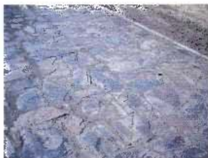
Fotografía N° 14. Se muestra la instalación de revestimiento en piedra de la zona.
