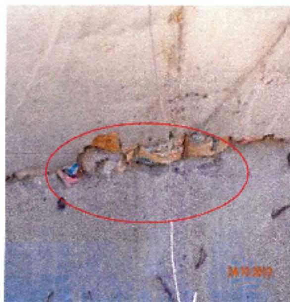
Fotografía N°26: Presencia de papel y maderas en estructura de hormigón en cúpula de Zona B.
