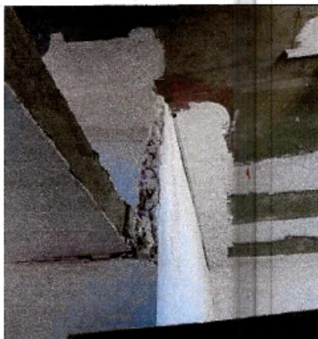
Fotografía N° 19: Revestimiento de estucos
