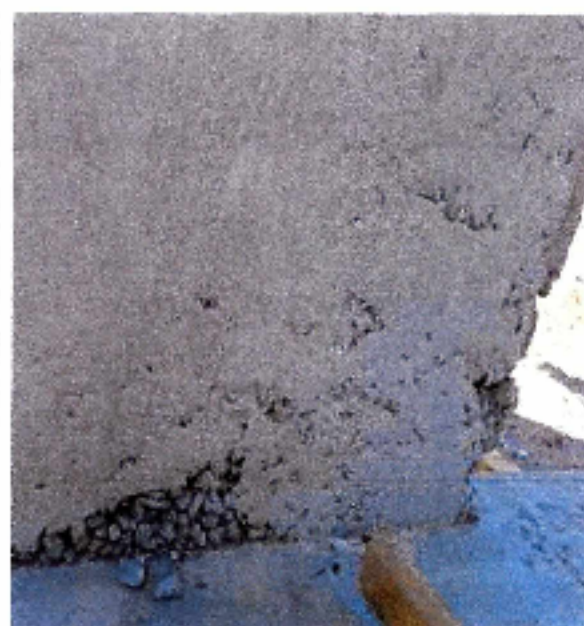
Fotografía N° 22: Presencia de nidos de piedra en base de muro en acceso edificio administración, Zona A.
