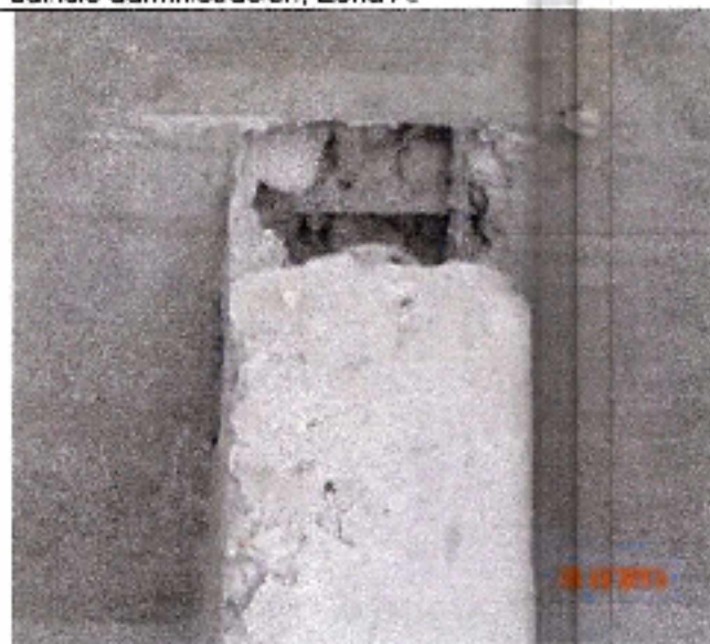
Fotografía N° 21: Presencia de nidos de piedra y fierro descubierto en base de muro en acceso edificio administración, Zona A.
