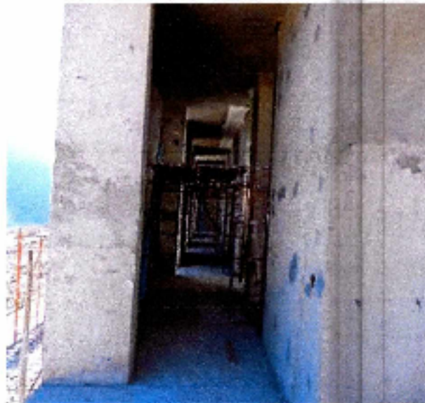
Fotografía N° 7: Zona A sin ejecución de partidas de tabique y terminaciones
