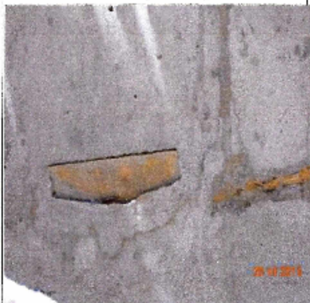
Fotografía N°26: Presencia de papel y maderas en estructura de hormigón en cúpula de Zona B.
