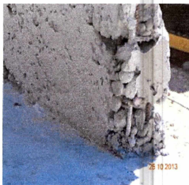
Fotografía N° 21: Presencia de nidos de piedra y fierro descubierto en base de muro en acceso edificio administración, Zona A.
