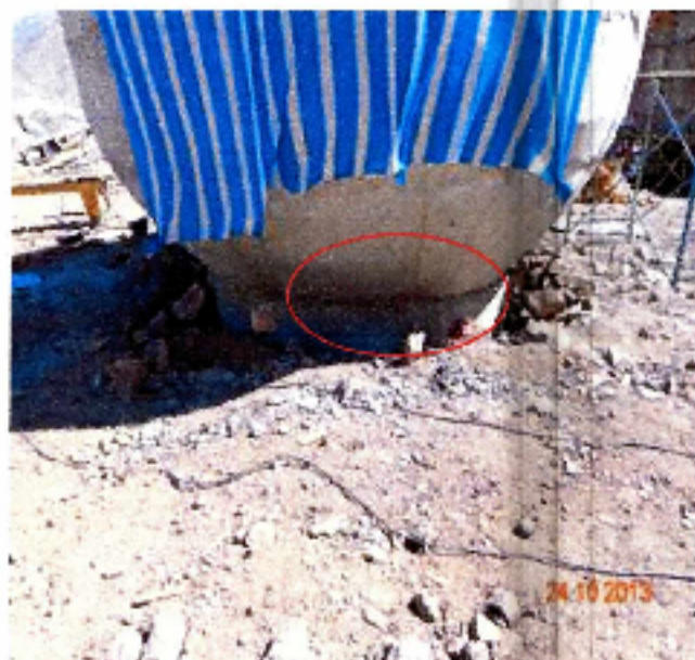
Fotografía N°25: Presencia de papel y maderas en estructura de hormigón en cúpula de Zona B.
