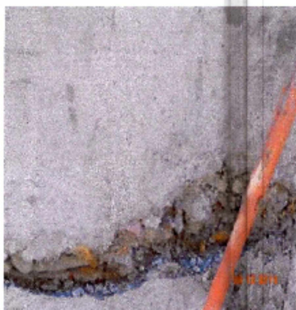
Fotografía N° 29: Presencia de maderas y nidos de piedra en estructura de hormigón del edificio de recepción, Zona B.
