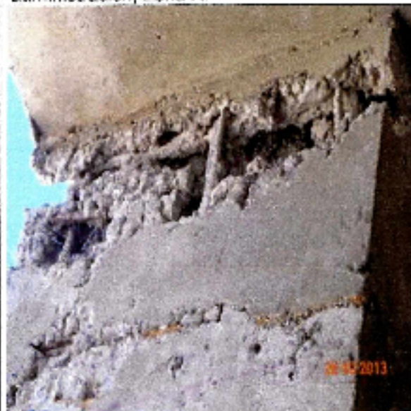
Fotografía N° 22: Presencia de nidos de piedra en base de muro en acceso edificio administración, Zona A.
