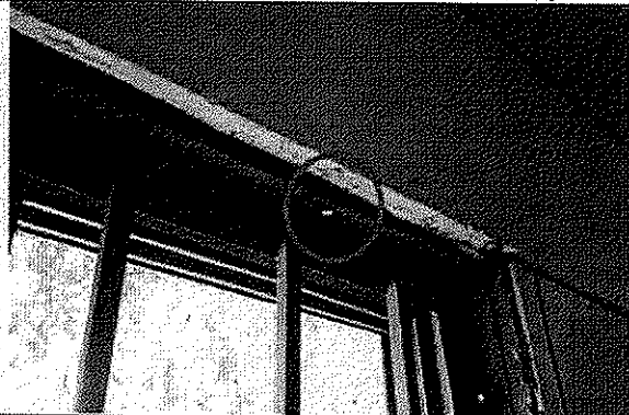
Fotografía N° 7: Falta de fijación en la reja de protección de la ventana.
