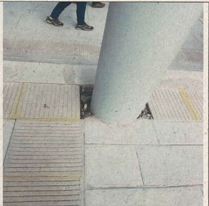
Fotografía N°14. Detalle en base de sombreaderos.
