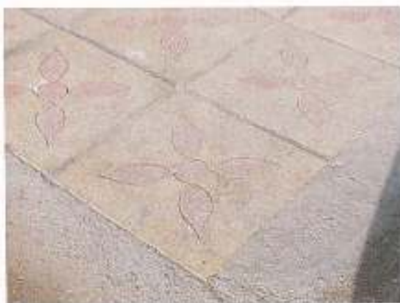
Foto N°3 Detalle baldosa 50x50 cms.
