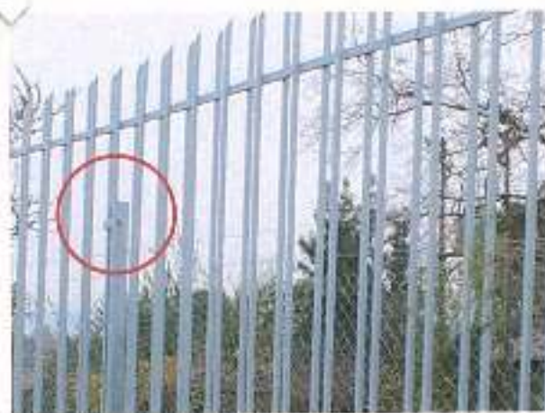
Foto N°3 Suple metálico para soldar módulo de la reja al pilar
