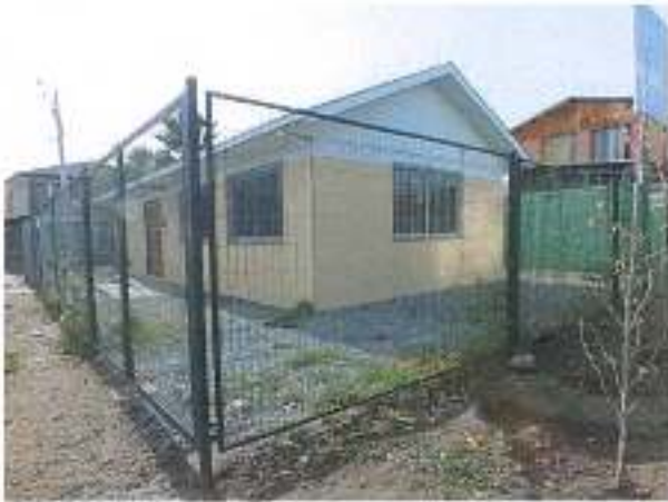
Foto N°1 Sede y cierre perimetral, vista anterior
