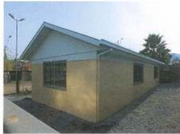
Foto N°2 Sede, vista posterior
