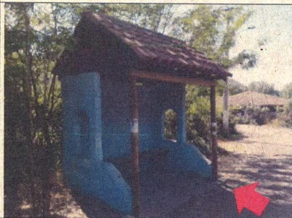
Fotografía N°3: Paradero de locomoción colectiva emplazado en sector "Camino asentamiento Chillehue", con desnivel y sin conexión al tránsito peatonal.
