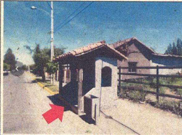
Fotografía N°1: Paradero de locomoción colectiva emplazado en sector "entrada el cajón, Copequén", con desnivel y sin conexión al tránsito peatonal.
