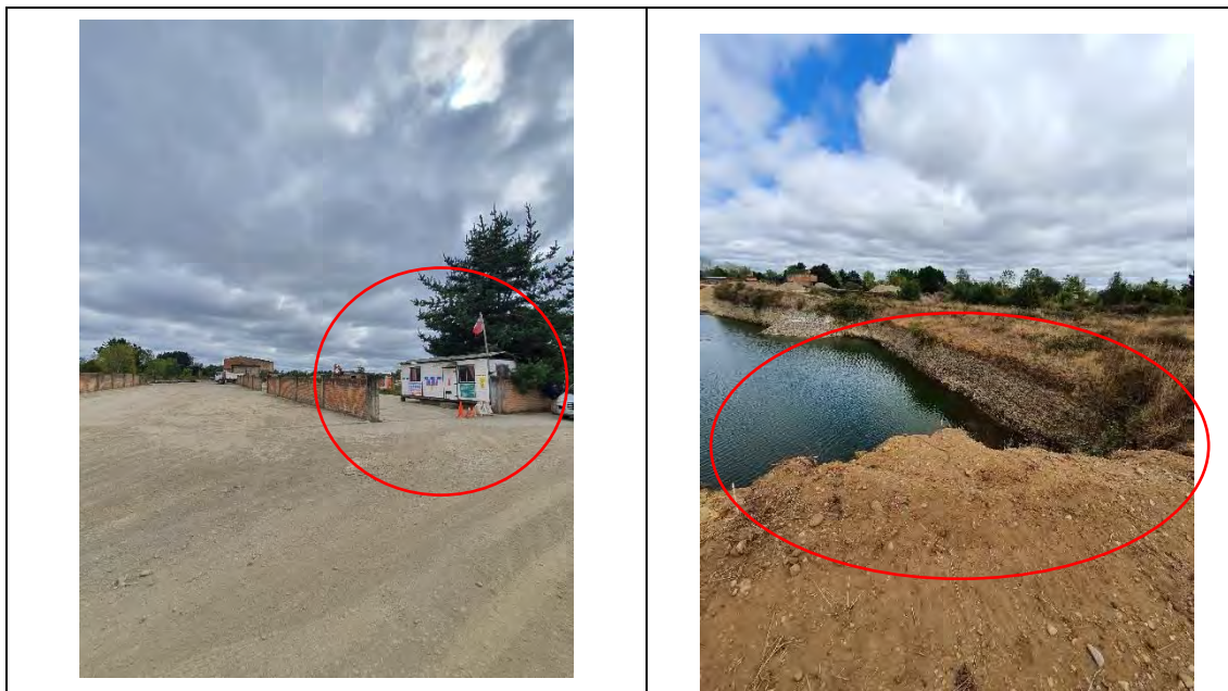
Fotografía N° 2: Contenedores con recintos habitables (oficinas)
