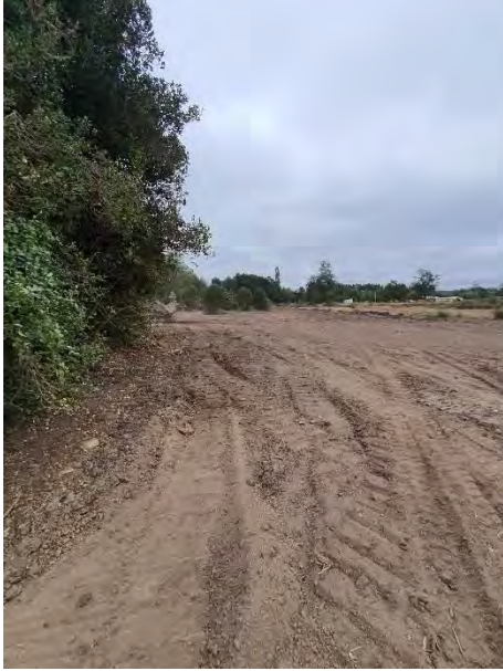
Fotografía N° 4: Extracción Fundo Las Vegas
