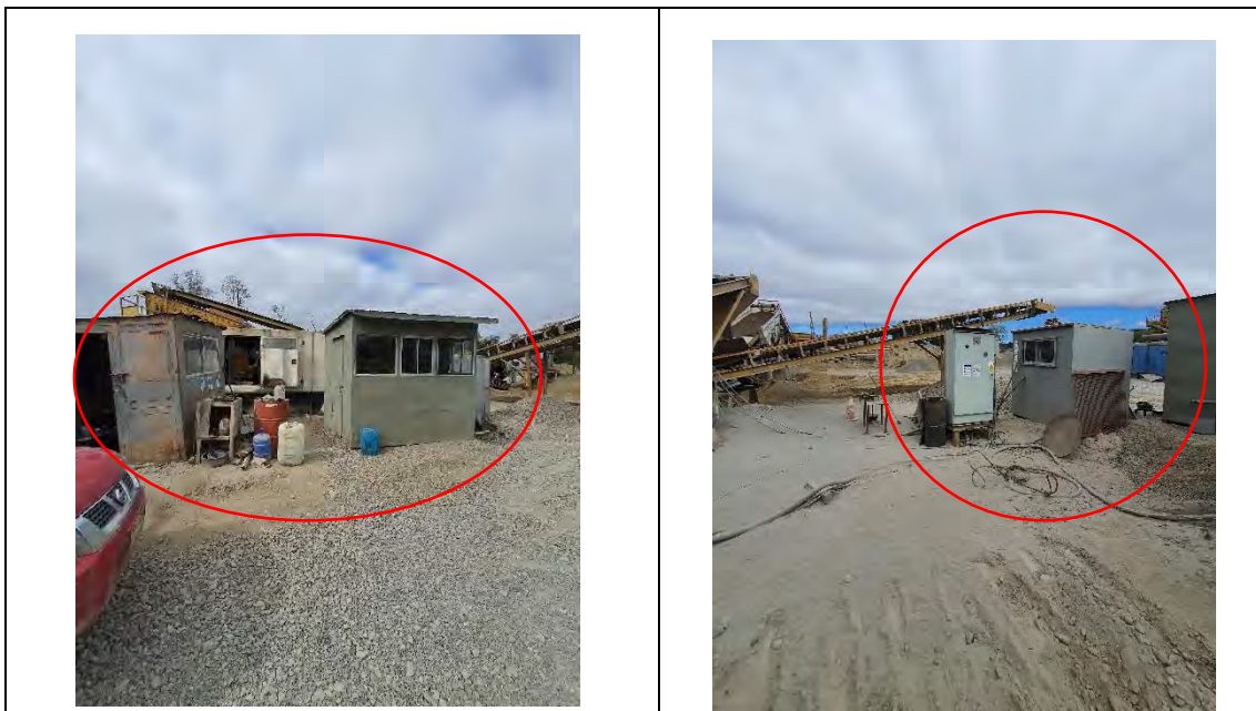
Fotografía N° 2: Construcciones en el terreno de la faena
