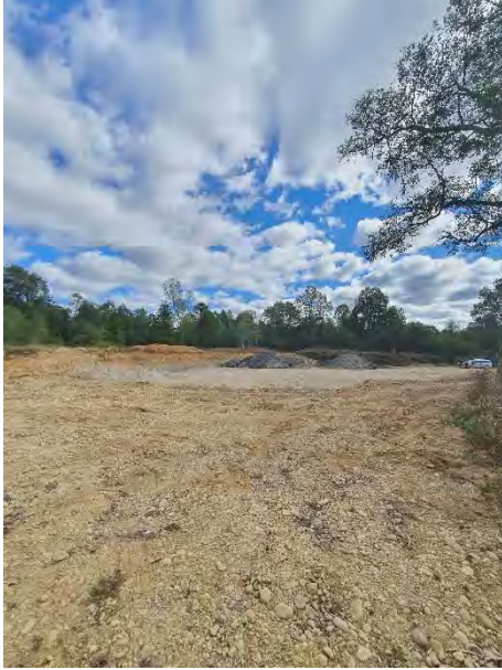
Fotografía N° 4: Extracción pozo Cañal Bajo
