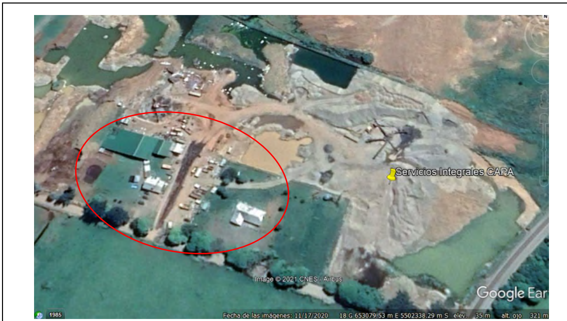
Fotografía N° 1: Construcciones y contenedores en pozo Fundo Santa Laura - CAPA
