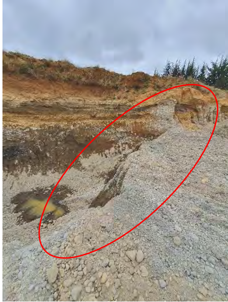
Fotografía N° 4: Falta señalización peligro de caídas.
