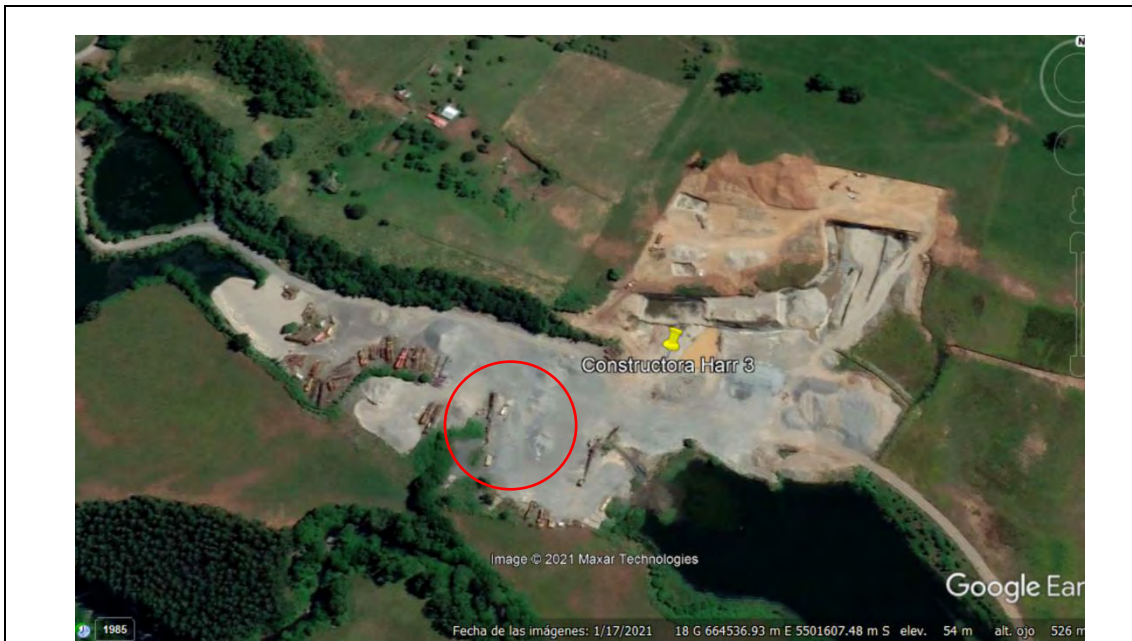
Fotografía N° 1: Contenedores y construcciones pozo Cañal Bajo (Hadida) – Constructora Harr
