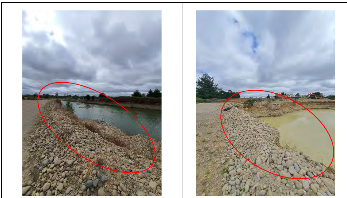
Fotografía N° 5: Falta señalización zona de peligro caídas.
