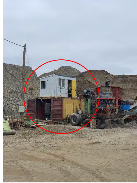
Fotografía N° 5: Construcciones con recintos habitables en la faena
