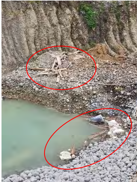
Fotografía N° 6: Acumulación de residuos en la zona de trabajo.
