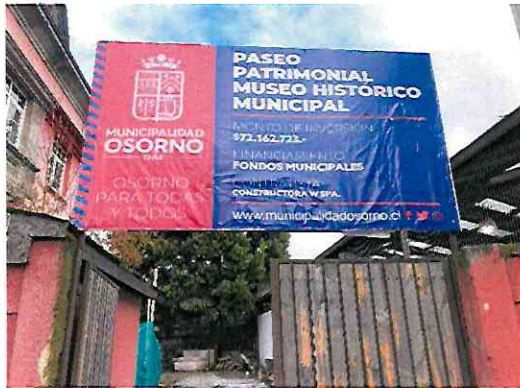
Imagen 1: Letrero de obra ubicado en acceso por calle Francisco Bilbao.
