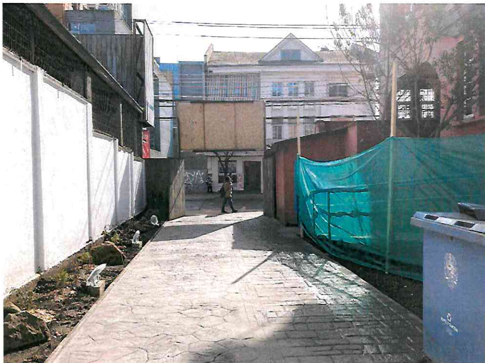
Imagen 3: Pavimento estampado en acceso por calle Francisco Bilbao.
