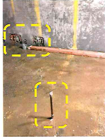
Imagen 8: Ejecución de proyecto sanitario en obras sector baño funcionarios del primer nivel.
