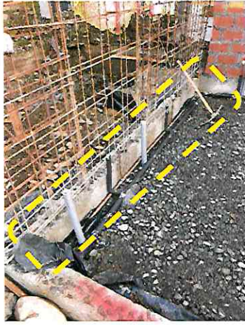
Imagen 7: Ejecución de proyecto sanitario en obras sector lavandería.
